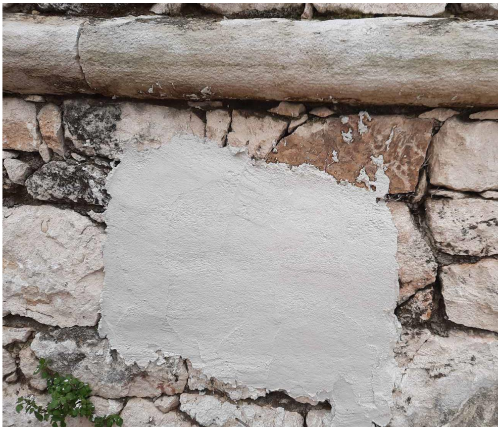
Εικόνα 42: Εφαρμογή υλικού σε εξωτερική επιφάνεια πεσσού
