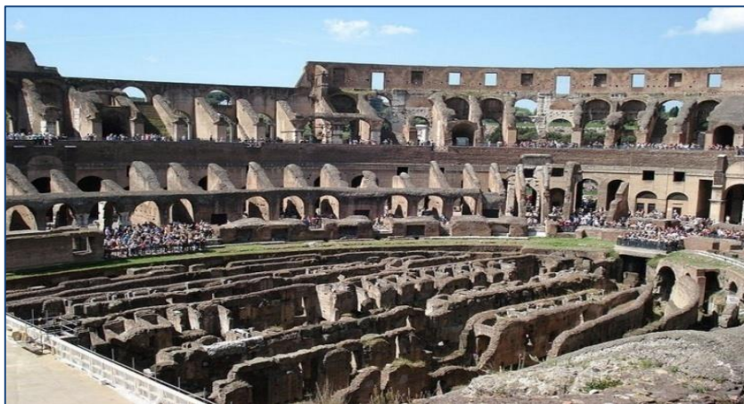
Εικόνα 1. Το Κολοσσαίο και ιδίως τα εσωτερικά τοιχώματα χτίστηκαν με σκυρόδεμα από ηφαιστειακή τέφρα και άσβεστο.
