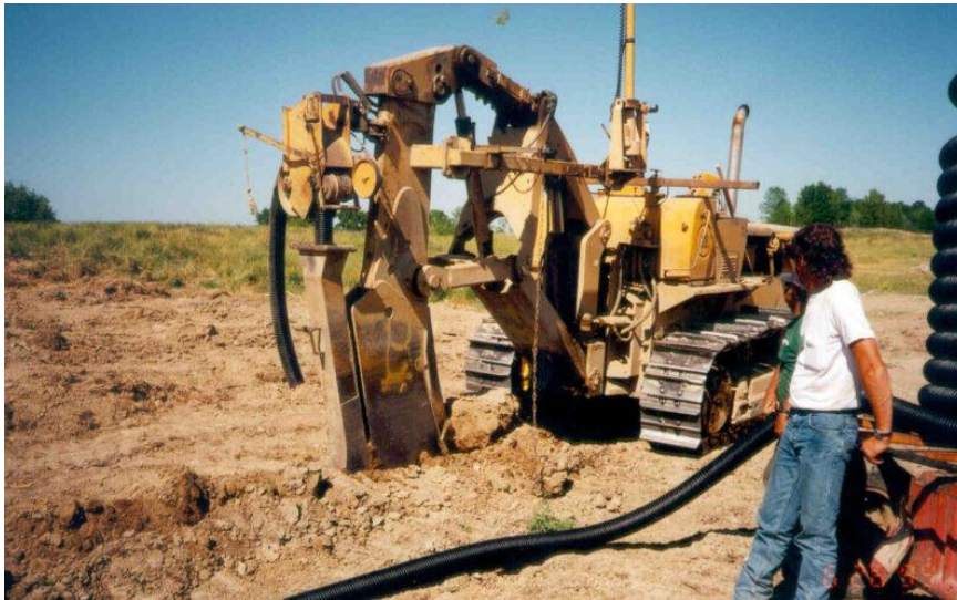
Σχήμα 3.18 Εγκατάσταση συστήματος απορροής υδάτων ( https://walkeraggregates.com/featured-case-study )
