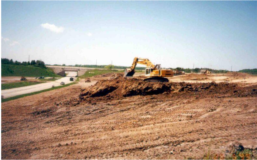
Σχήμα 3.17 Διαμόρφωση των υπερκείμενων υλικών του λατομείου στη 1η φάση του έργου ( https://walkeraggregates.com/featured-case-study )
