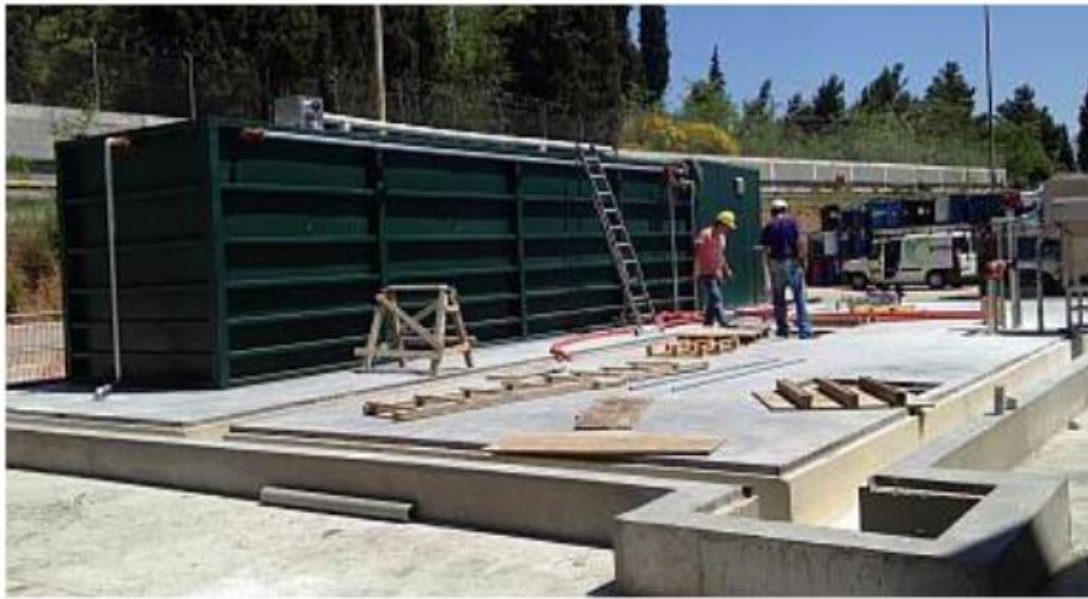
Εικόνα 11 : Τυπική διάταξη compact μονάδας MBBR σε container
