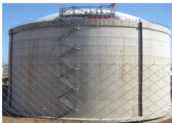
Εικόνα 4.5. Δεξαμενή ΥΦΑ σεισμικά μονωμένη με TFPB στο Quintero, Χιλή (EPS, 2019).
