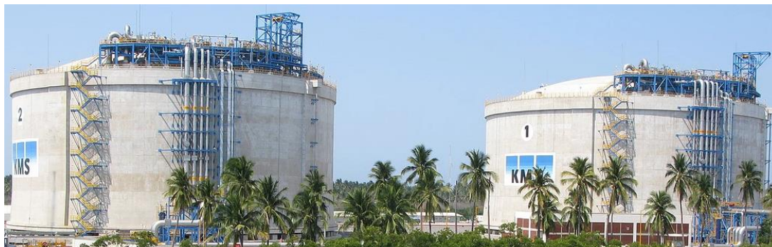
Εικόνα 4.6. Δεξαμενές ΥΦΑ σεισμικά μονωμένες με TFPB στην Colima, Μεξικό (EPS, 2019).
