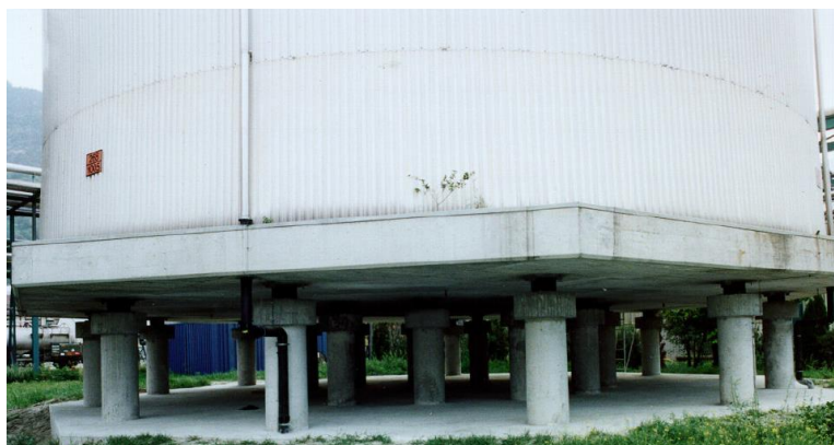
Εικόνα 4.4. Δεξαμενή αποθήκευσης χημικών σεισμικά μονωμένη με HDRB στο Visp, Ελβετία (Marioni, 1998).
