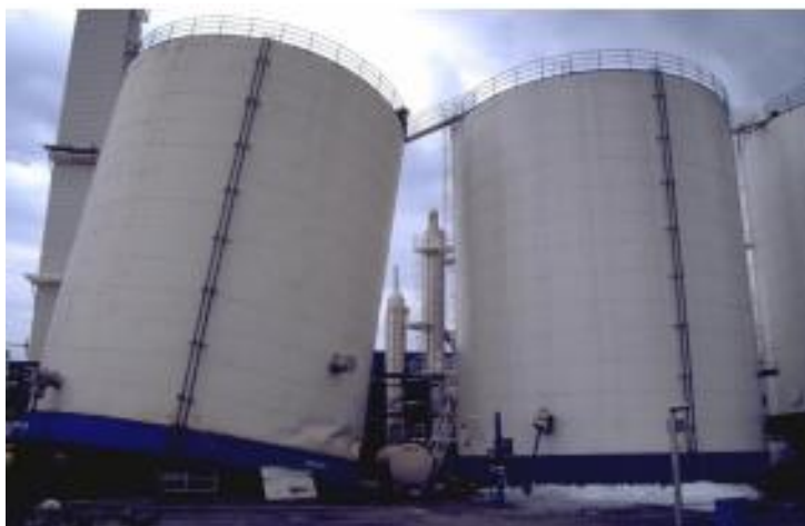
Εικόνα 2.16. Αστοχία υποστυλωμάτων σε δεξαμενές της εγκατάστασης Habas (Sezen et al., 2000).
