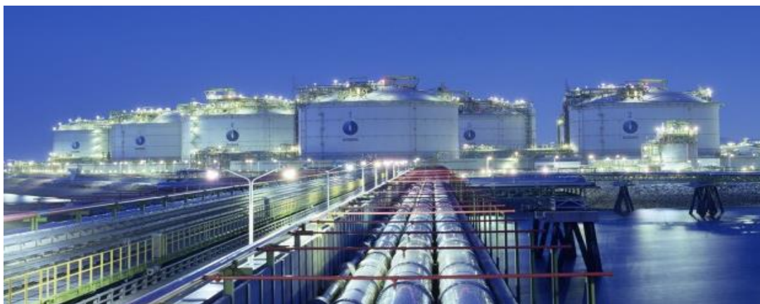
Εικόνα 4.3. Δεξαμενές ΥΦΑ σεισμικά μονωμένες με LRB στην Inchon, Κορέα (www.lngworldnews.com).
