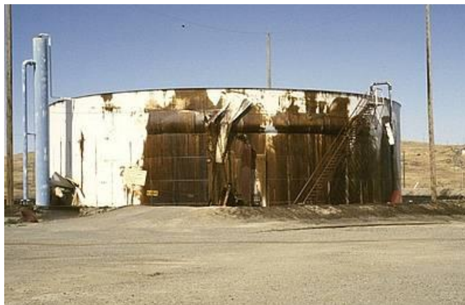
Εικόνα 2.15. Διαρροή πετρελαίου από την κορυφή σε δεξαμενή μετά το σεισμό Coalinga ( https://www.edac.biz/en/research/earthquakes/structures-and-building-types/structures-of-high-risk-potential-special-structures/ ).
