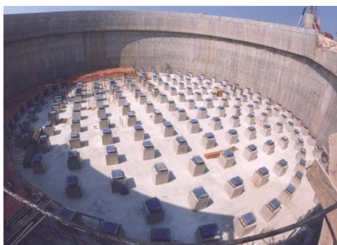
Εικόνα 4.7. Δεξαμενές ΥΦΑ στη Ρεβυθούσα με εφέδρανα SFPB (EPS, 2011).
