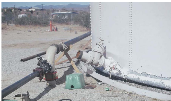
Εικόνα 2.10. Αποκόλληση του ακροφυσίου σε δεξαμενή αποθήκευσης υγρών ( www.apwa.net ).
