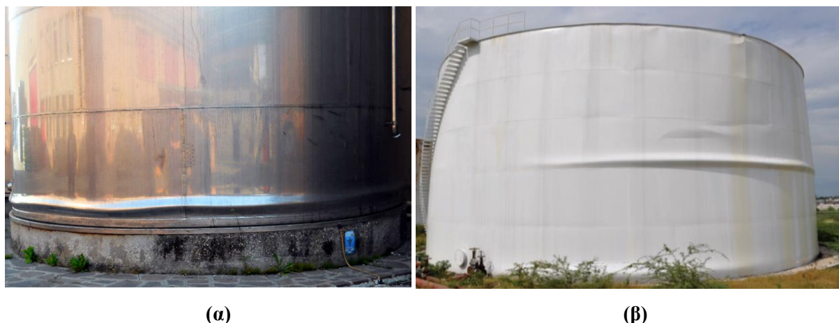
Εικόνα 2.6. Λυγισμός μορφής (α) πόδα ελέφαντα στη βάση δεξαμενής κατά το σεισμό Emilia, 2012 (Buratti and Tavano, 2014), (β) γονάτου ελέφαντα κατά το σεισμό της Αϊτής, 2010 ( https://www.fema.gov/fema-e-74-reducing-risks-nonstructural-earthquake-damage ).
