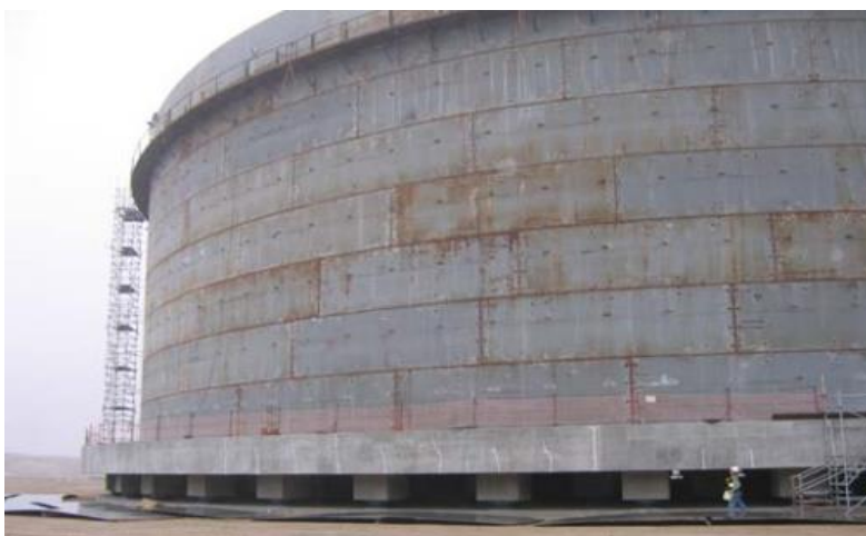
Εικόνα 4.8. Δεξαμενή ΥΦΑ στη Melhorita, Περού με εφέδρανα TFPB (EPS, 2011).
