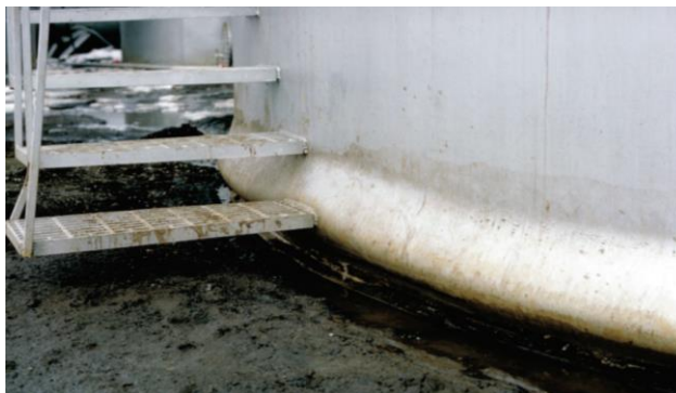
Εικόνα 2.12. Λυγισμός μορφής πόδα ελέφαντα στη βάση δεξαμενής κατά τον σεισμό στην Αλάσκα, 1964 ( https://www.fema.gov/fema-e-74-reducing-risks-nonstructural-earthquake-damage , Steinbrugge Collection, No. S2508).
