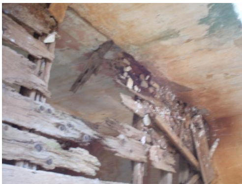
Εικόνα 64 Κατάρρευση των σανιδιών στο κλιμακοστάσιο
