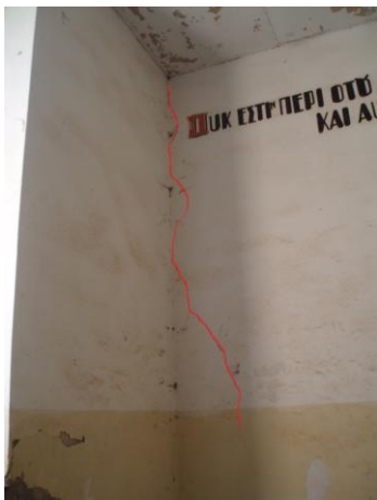
Εικόνα 58: Ρωγμή σε εσωτερική τοιχοποιία
