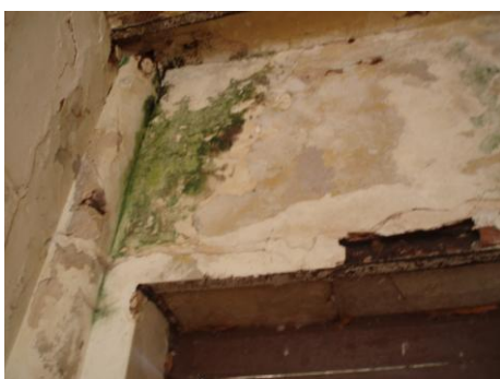
Εικόνα 59: Ύπαρξη ριζικών συστημάτων στην τοιχοποιία
