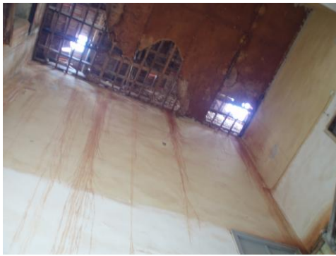
Εικόνα 63 Κατάρρευση ξύλινων στοιχείων στο κλιμακοστάσιο
