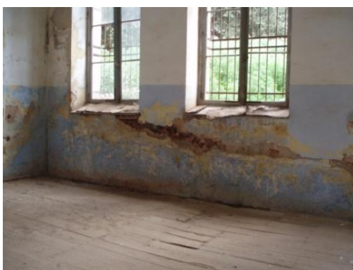
Εικόνα 61: Αποκόλληση κονιάματος
