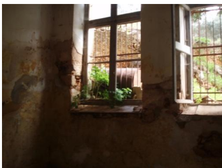
Εικόνα 66 Παραμορφώσεις στα ξύλινα στοιχεία των ανοιγμάτων
