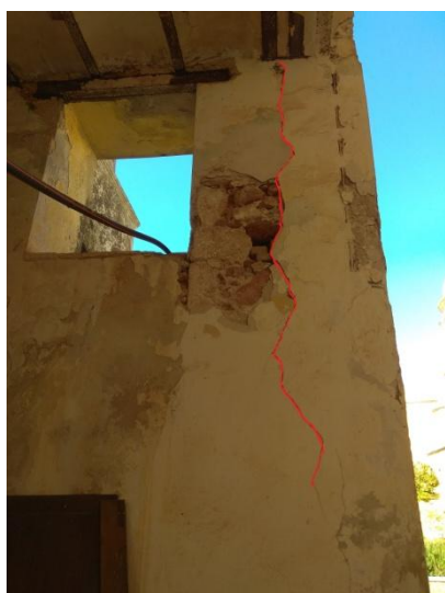
Εικόνα 57: Ρωγμή στην δυτική τοιχοποιία
