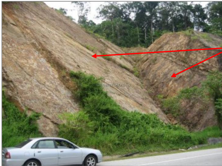
Εικόνα 2.3: Μορφή σφηνοειδούς αστοχίας βράχου (Μαρίνος, 2011).
