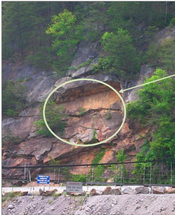
Εικόνα 2.2: Μορφή επίπεδης αστοχίας βράχου (Μαρίνος, 2011).
