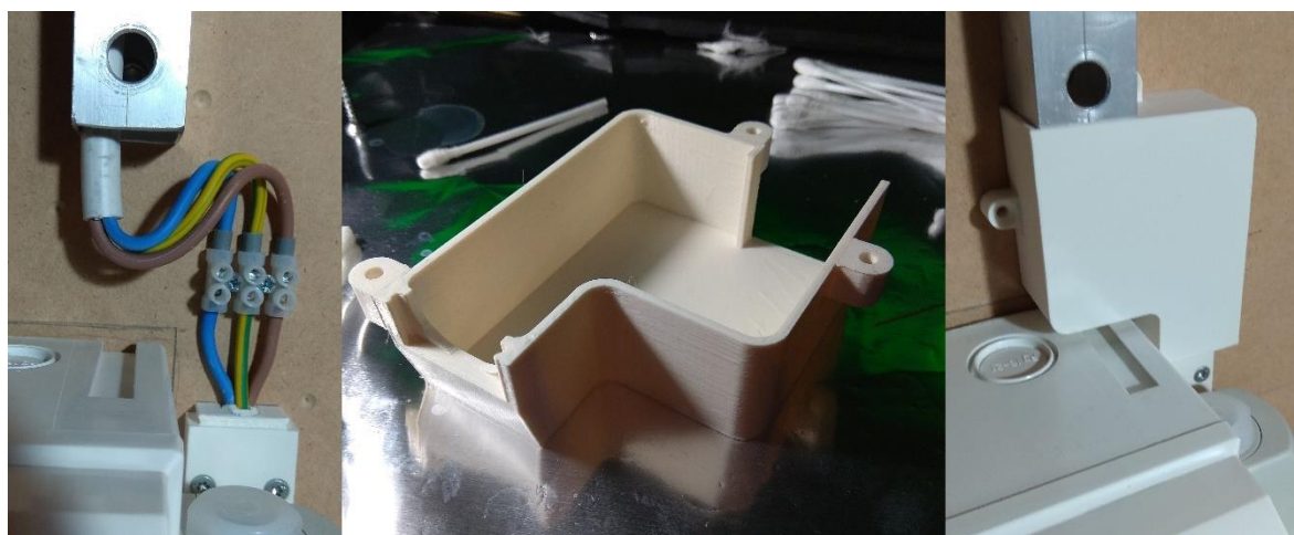
Σχήμα 3.40: Λεπτομέρειες από τη σύνδεση του φούρνου.
