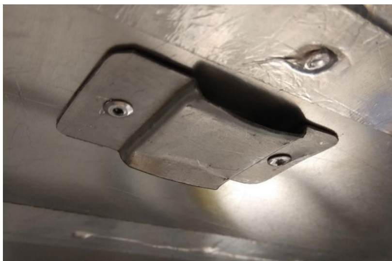
Σχήμα 3.11: Λεπτομέρεια, Εσωτερική όψη της οπής εξαερισμού του φούρνου.
