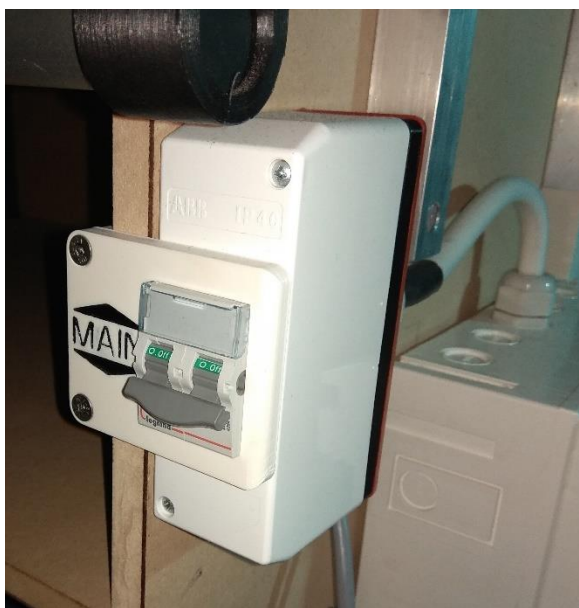
Σχήμα 3.32: Υποπίνακας με τον κεντρικό διακόπτη λειτουργίας. Στο πίσω μέρος είναι ορατή η σύνδεση με τον κύριο πίνακα.
