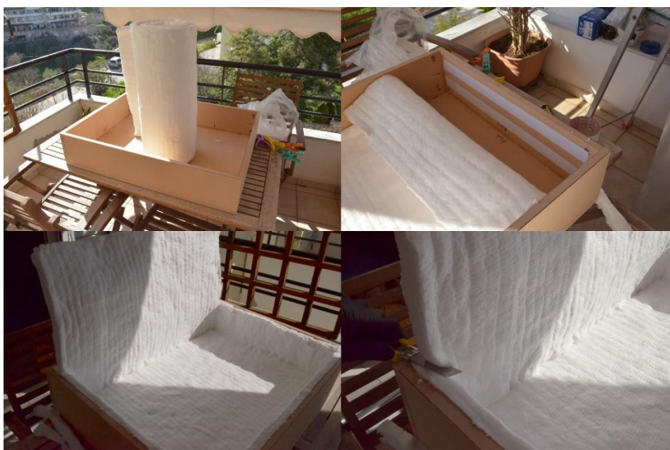
Σχήμα 3.9: Τοποθέτηση κεραμοβάμβακα
