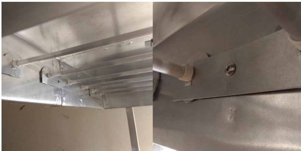
Σχήμα 3.10: Λεπτομέρειες από την έδραση των λαμπτήρων. Σήμανση ελασμάτων
