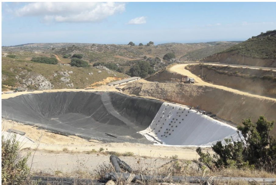
Εικόνα 6: Κύτταρο ΧΥΤΑ έτοιμο προς πλήρωση.
