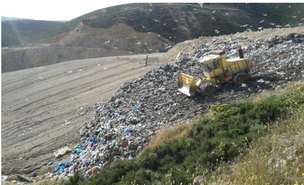
Εικόνα 3: Διάστρωση ΑΣΑ σε ενεργό κύτταρο του ΧΥΤΑ Αμαρίου.
