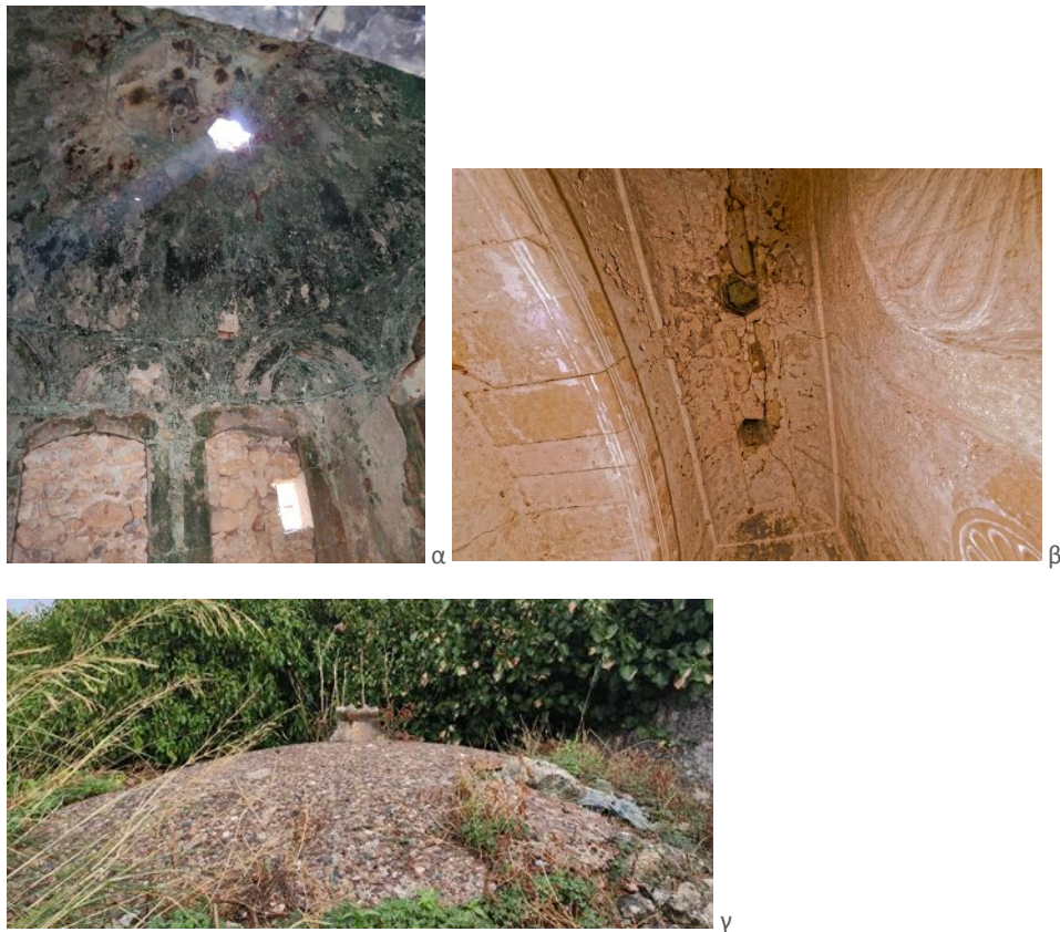
Εικόνα 38: α) φωτιστική οπή ψυχρού χώρου, β) φωτιστικές οπές ενδιάμεσου χώρου, γ) άποψη θόλου ψυχρού χώρου
