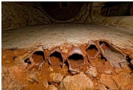
Εικόνα 30: α) εσωτερική ανατολική όψη θερμού χώρου, β1,2) απόψεις πηλοσωλήνων στο εσωτερικό της τοιχοποιίας
