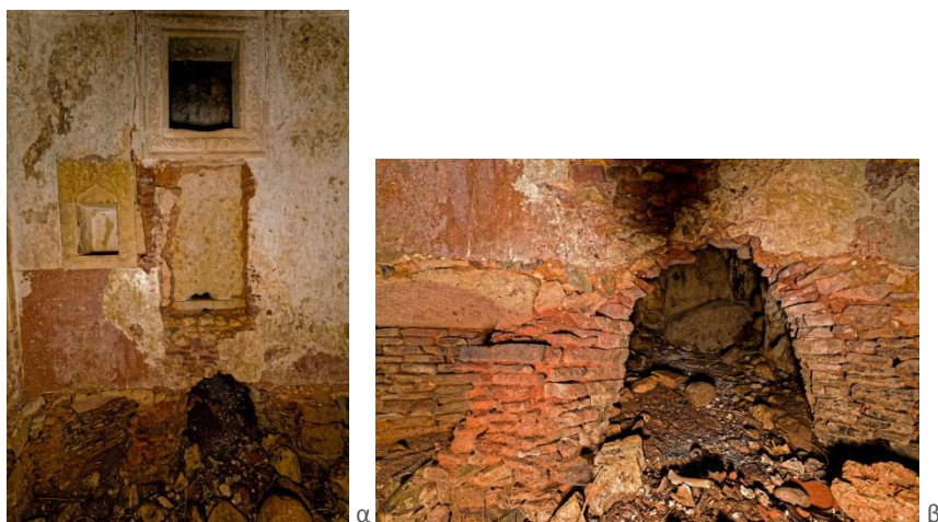
Εικόνα 26: α) άνοιγμα θερμού χώρου το οποίο επικοινωνεί με την δεξαμενή του ζεστού νερού, β) άνοιγμα από το οποίο περνούσε ο καπνός από την καύση των ξύλων στον θερμό χώρο
