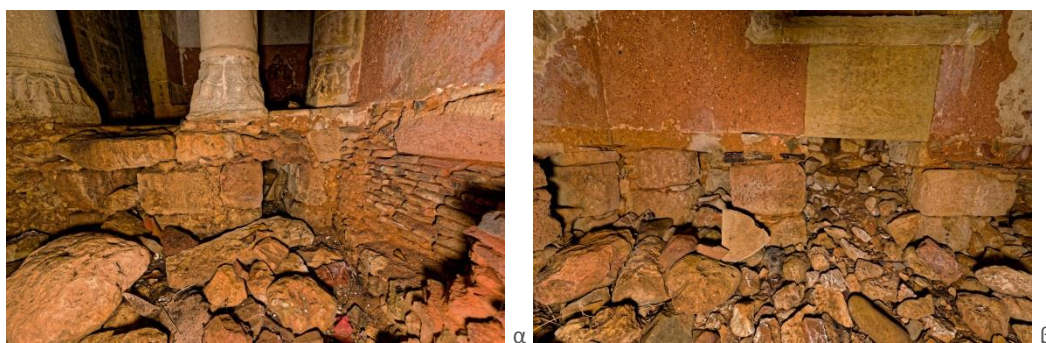
Εικόνα 27: α) κενά υποκαύστων κάτω από τους κίονες, β) κενά υποκαύστων στην τοιχοποιία ώστε να περνάει ο καπνός μέσα στους πηλοσωλήνες
