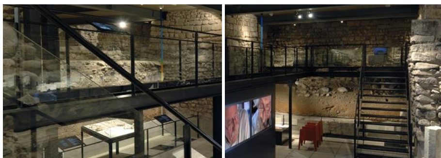
Εικόνα 74: απόψεις της μεταλλικής πλατφόρμας και σκάλας σε σχέση με το υφιστάμενο κτίριο, Αρχαιολογικός Χώρος Καθεδρικού Ναού του Αγ. Πέτρου, Γενεύη
