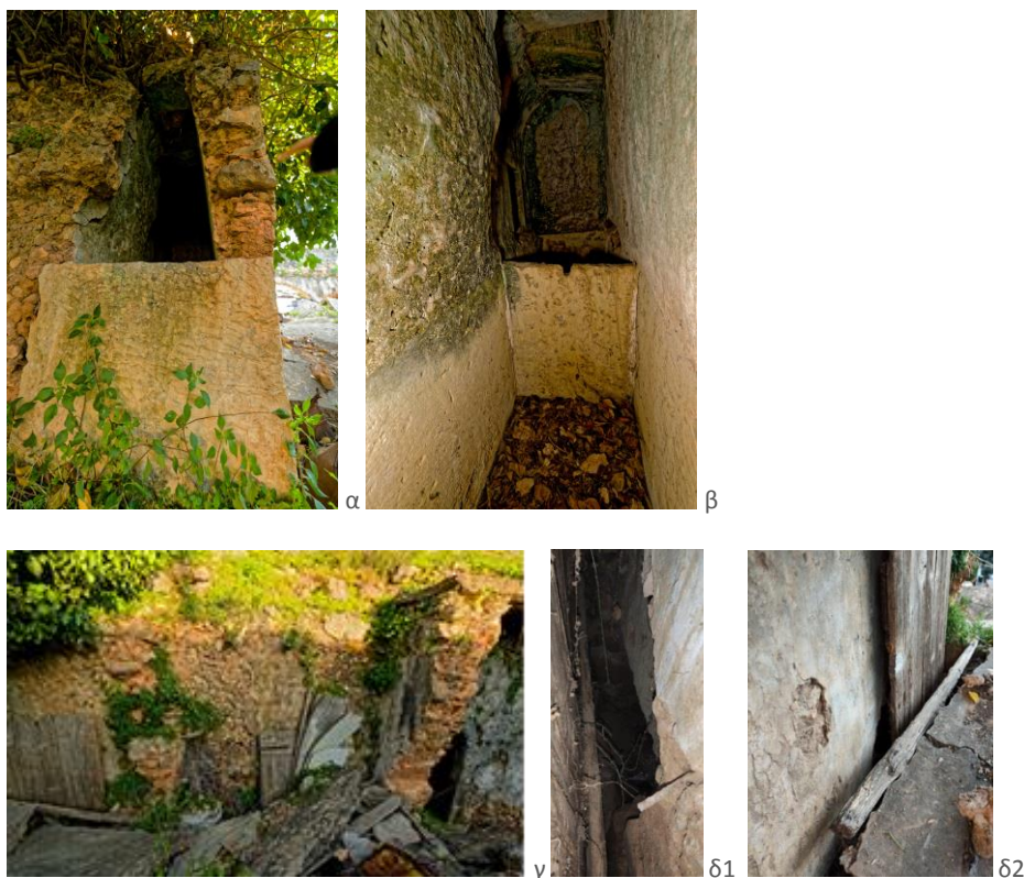
Εικόνα 25: α) εξωτερική άποψη της δεξαμενής, β) εσωτερική άποψη της δεξαμενής σε πρώτο πλάνο και σε δεύτερο ο χώρος με το καζάνι, γ) εξωτερική δυτική άποψη, δ1,2) άνοιγμα τροφοδοσίας ξύλων το οποίο έχει κλείσει με ξύλα
