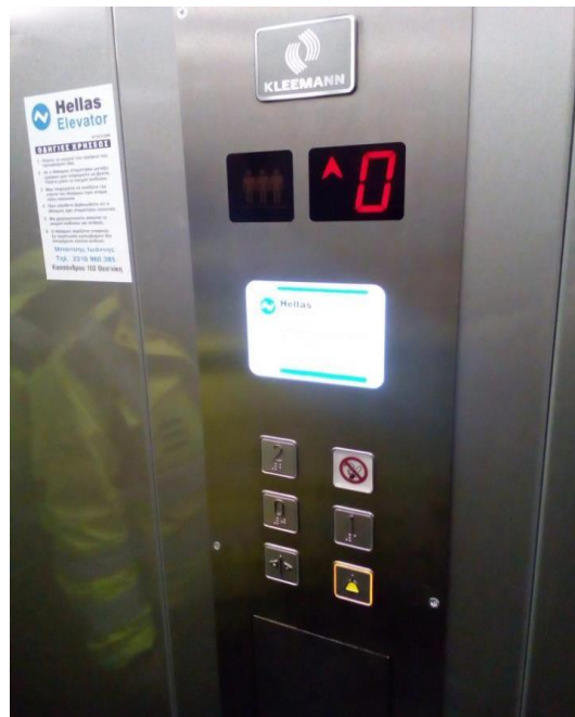
Σχήμα 2.6: Κομβιοδόχος θαλάμου ανελκυστήρα σύμφωνα με τα αρμόδια πρότυπα
