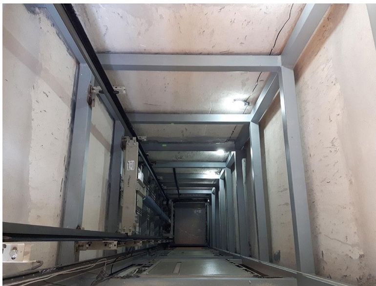
Σχήμα 2.4: Σιδηροκατασκευή-σασί θαλάμου μέσα στο φρεάτιο
