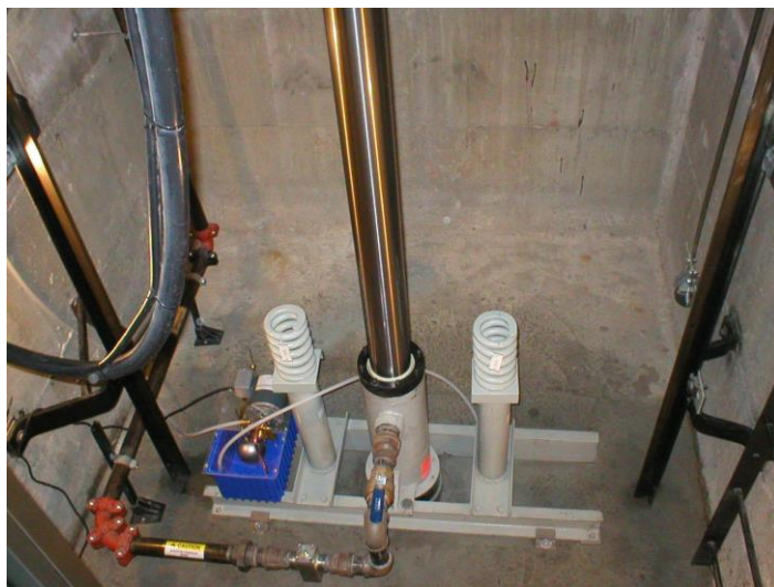
Σχήμα 4.1: Τμήμα εγκατάστασης υδραυλικού ανελκυστήρα που περιλαμβάνει, κύλινδρο, έμβολο, βάσεις, επικαθίσεις και αγωγούς διακίνησης του υδραυλικού μέσου
