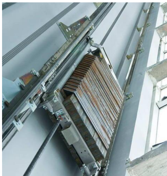
Σχήμα 2.10: Αντίβαρο μηχανικού ανελκυστήρα
