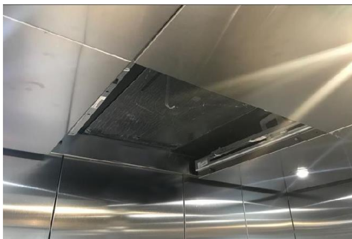
Σχήμα 2.5: Έξοδος εκτάκτου ανάγκης μέσω της οροφής του θαλάμου
