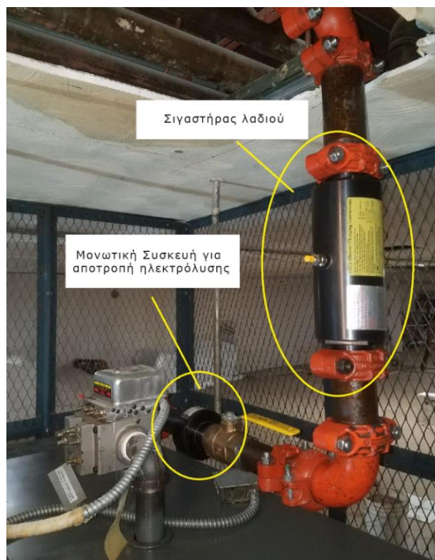
Σχήμα 4.12: Διάταξη μονωτικής συσκευής για αποτροπή ηλεκτρόλυσης & σιγαστήρας λαδιού.
