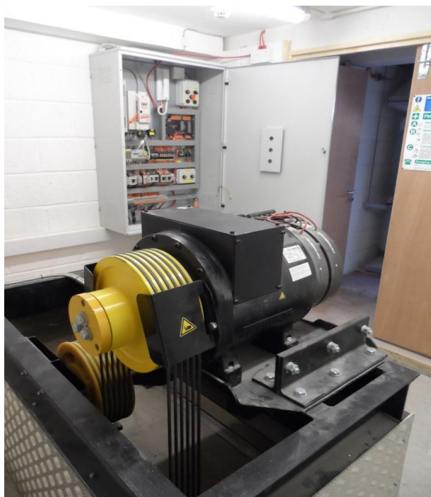
Σχήμα 2.18: Μηχανοστάσιο ανελκυστήρα
