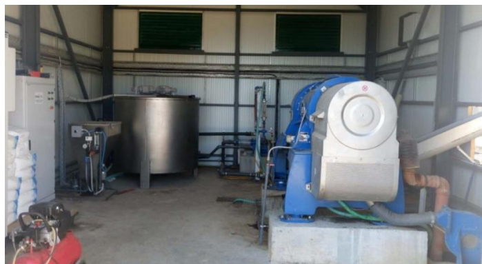
Εικόνα 12: Μονάδα φυγοκεντρικού διαχωριστήρα (Μονάδα επεξεργασίας στραγγισμάτων, n.d.).
