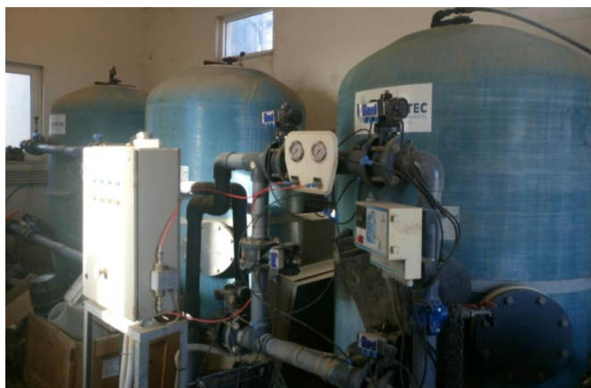
Εικόνα 13: Μονάδα ενεργού άνθρακα (Μονάδα Επεξεργασίας Στραγγισμάτων, n.d.).
