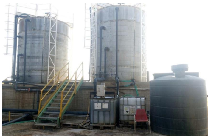
Εικόνα 11: Δεξαμενές θρόμβωσης-συσσωμάτωσης (Μονάδα επεξεργασίας στραγγισμάτων ,n.d.).
