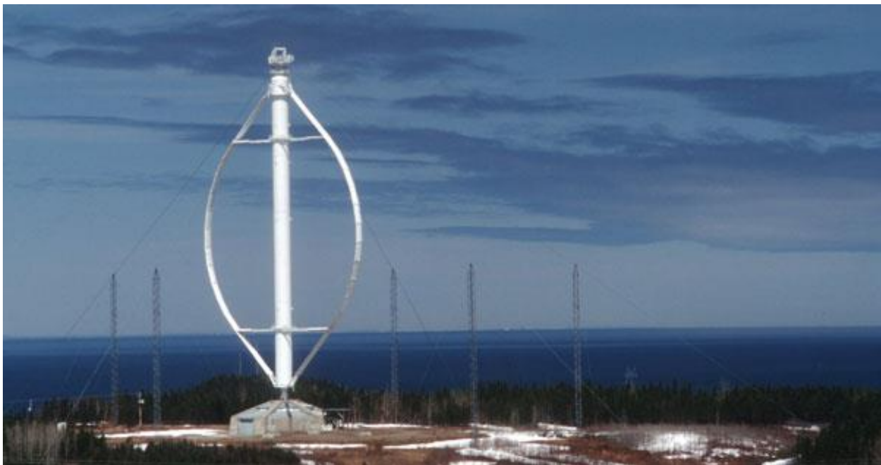
Εικόνα 1.29: Ανεμογεννήτρια κατακορύφου άξονα τύπου Darrieus [Πηγή: http://www.wind-works.org/cms/index.php?id=64&tx_ttnews%5Btt_news%5D=5322&cHash=345e48d80ec1772b603ffc838ab3a6e ].
