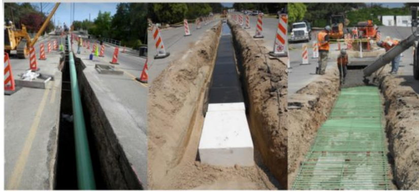
Σχήμα 2.19. Τοποθέτηση μπλοκ γεωφρών επάνω από θαμμένο αγωγό (Bartlett et al., 2015).
