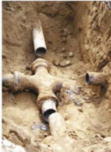
Σχήμα 2.4. Αποκόλληση διασταύρωσης αγωγών στον σεισμό San Fernando (Nair et al., 2018).
