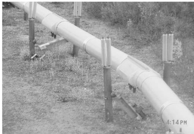
Σχήμα 2.10. Απώλεια δύο διαδοχικών στηρίξεων μετά τον σεισμό του 2002 (Hall et al., 2003).
