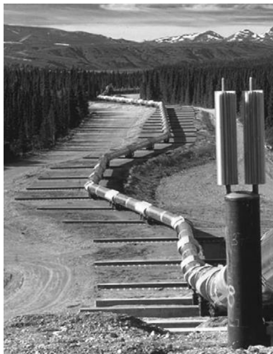
Σχήμα 2.9. Ράγες ολίσθησης του αγωγού TAPS στην περιοχή διασταύρωσής του με το ρήγμα Denali (Hall et al., 2003).
