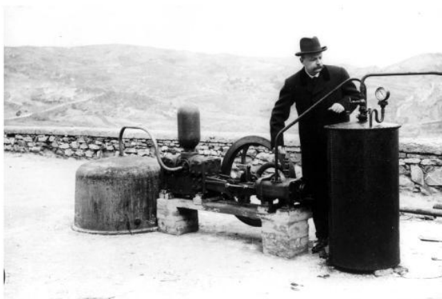
Σχήμα 4.3: Ο πρίγκιπας Piero Ginori Conti και η πειραματική διάταξη που χρησιμοποίησε το 1904 για παραγωγή ηλεκτρικής ενέργειας μέσω της γεωθερμίας [3]
