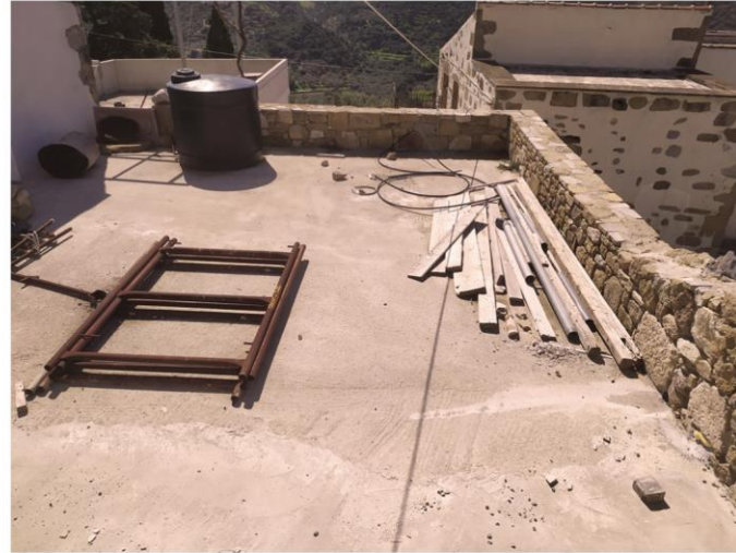
55| Κτίριο A_40 : κατασκευή υψηλού λίθινου στηθαίου στο δώμα.
