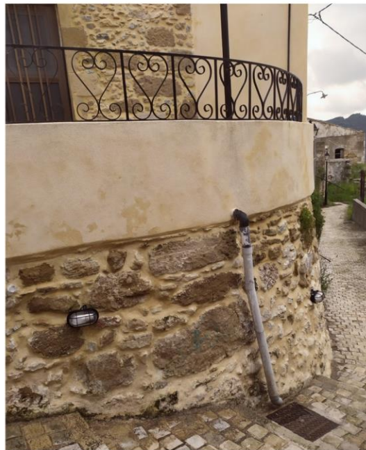
77| Κτίριο B_19 : προσθήκη σκυροδέματος και νέου τύπου κιγκλιδώματος πάνω σε υπάρχουσα λιθοδομή.
