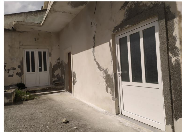
93 | Κτίριο B_27 : αποκόλληση επιχρίσματος.
