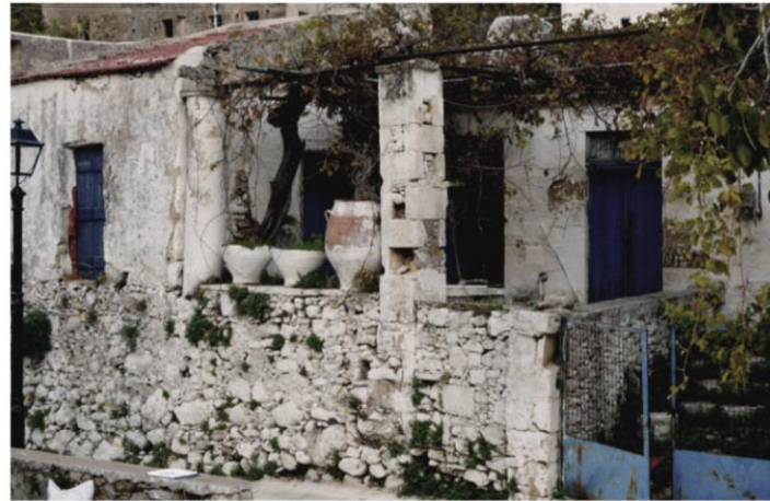
71, 72 | Κτίριο A_12: ήπια επέμβαση αρμολόγησης στη λίθινη τοιχοποιία.
