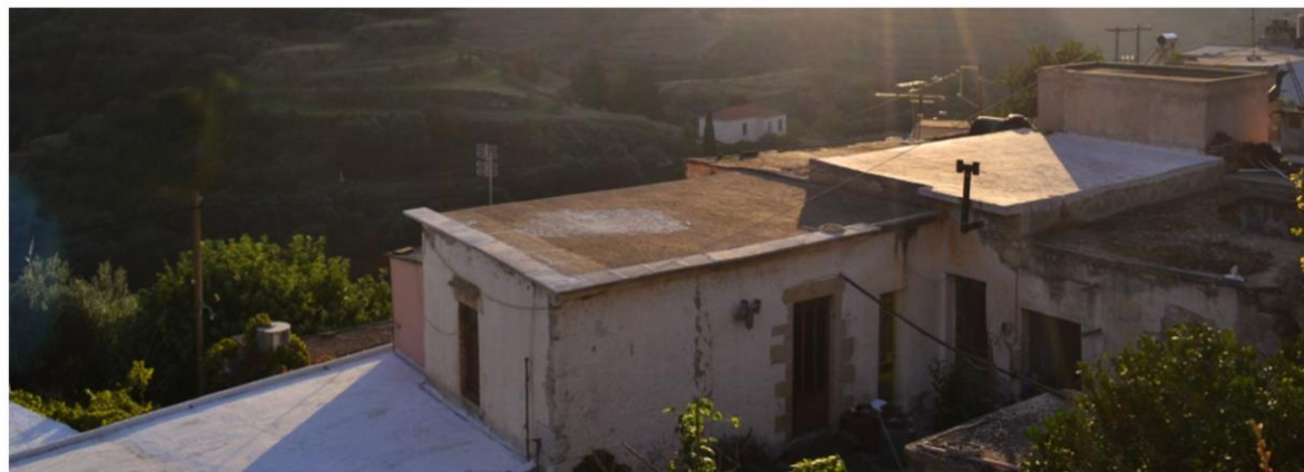
46 | αντικατάσταση της στέγης με πλάκες οπλισμένου σκυροδέματος, συμβατή προσθήκη.
