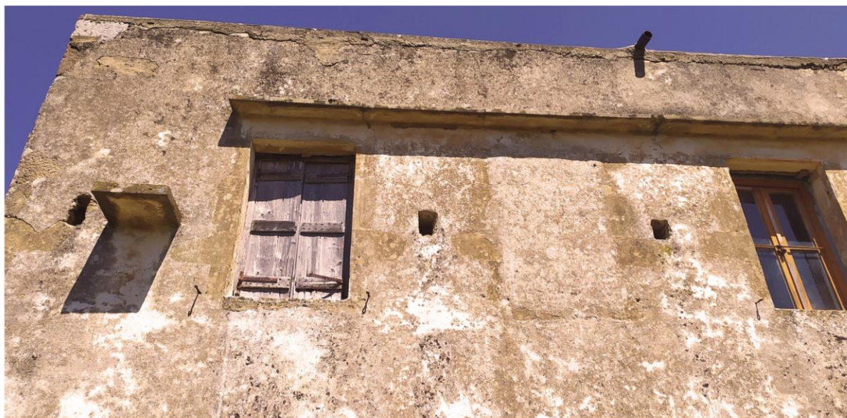
42| Κτίριο A_44: κάλυψη ανοίγματος, διατήρηση παραδοσιακού κουφώματος και αντικατάσταση με νέο.
