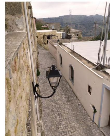
149, 150 | Τοποθέτηση υπερμεγεθών φαναριών σε δύο όψεις του κτιρίου, μη συμβατή επέμβαση.
