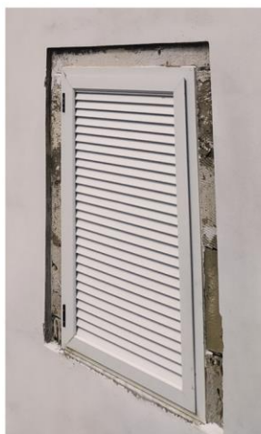
44| Κτίριο B_31 : κουφώματα αλουμινίου και επέμβαση σε άνοιγμα.
