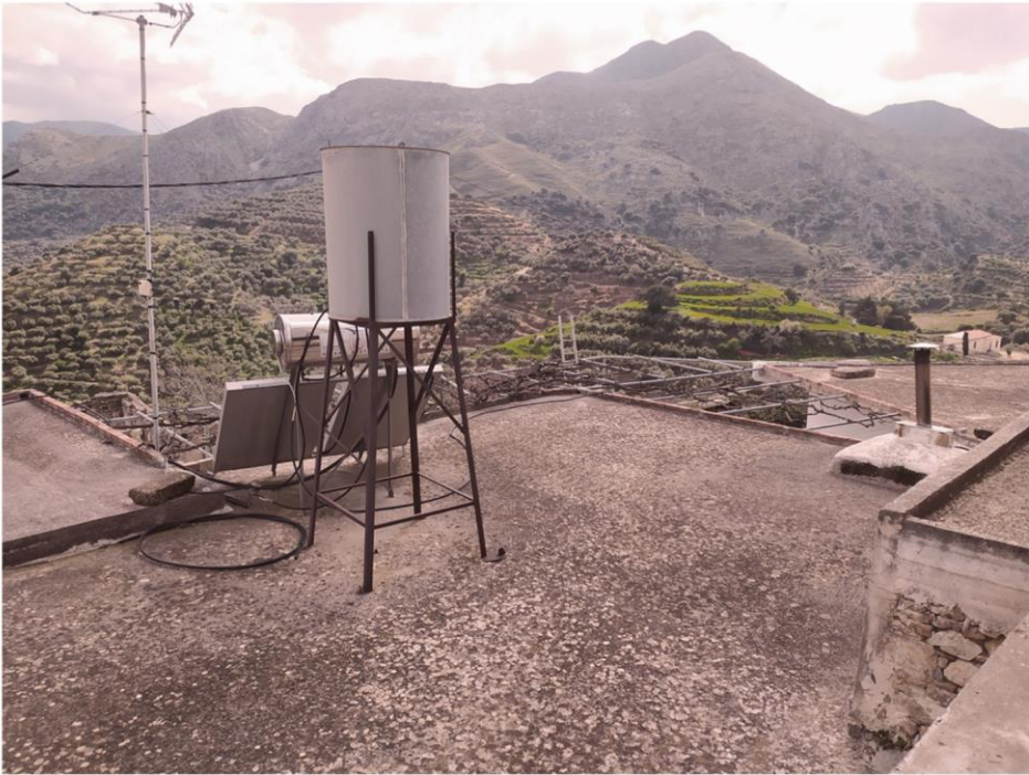
54| A_28 : ηλιακοι θερμοσίφωνες και δεξαμενές στα δώματα.
