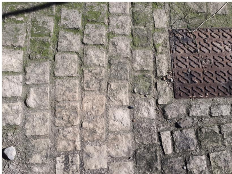
113|Πέτρινοι κυβόλιθοι πάχους 6 εκ. τετραγωνικού σχήματος διαστάσεων 10x10 εκ. απόχρωσης γκρι.
