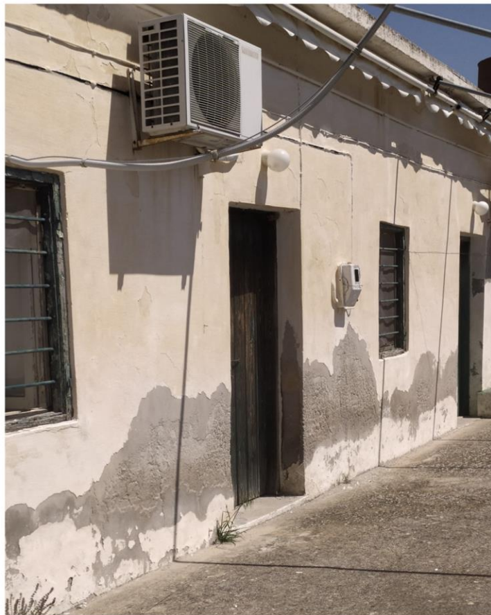
92 | Κτίριο A_33 : επιφανειακή φθορά όψης.
