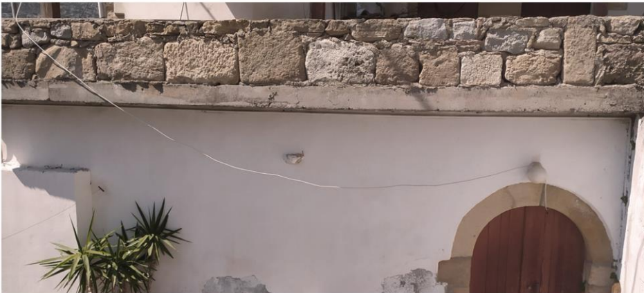
56, 57 | Κτίριο A_26 : αντικατάσταση δώματος με πλάκα από οπλισμένο σκυρόδεμα που δημιουργεί προεξοχή και κατασκευή λίθινου στηθαίου.
