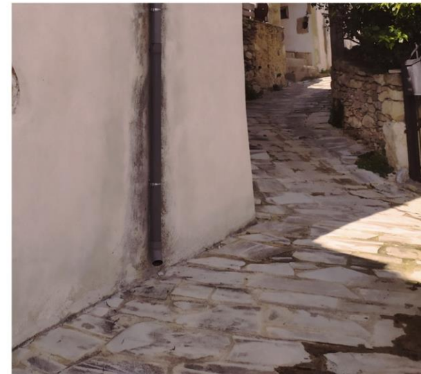
112| Λίθοι ακανόνιστου σχήματος πάχους 15 εκ. απόχρωση ανοιχτής ώχρας.
