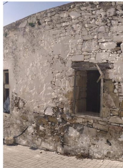
30| Κτίριο B_45 : ασπρισμένη τοιχοποιία με παλιό επίχρισμα.
