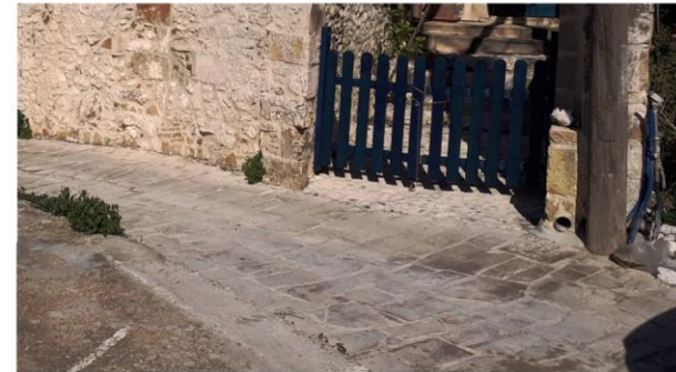
110| Επίστρωση με πέτρινες πλάκες πάχους 4εκ. ακανόνιστου σχήματος και απόχρωσης ανοιχτής ώχρας.
