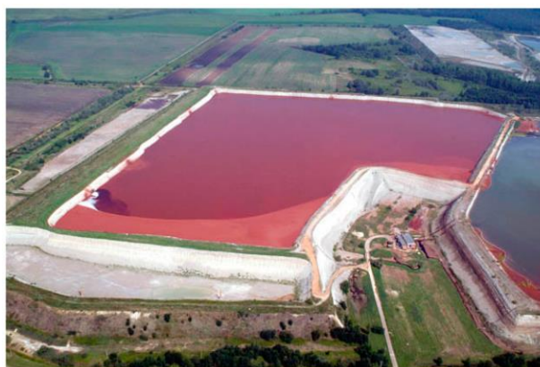
Εικόνα 2.8: Τεχνητός ταμιευτήρας διάθεσης των υγρών υπολειμμάτων επεξεργασίας του βωξίτη
