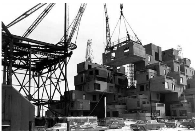
Εικόνα 24: Η μεταφορά των προκατασκευασμένων μονάδων στο οικοπέδο. Πηγή: https://www.archdaily.com/404803/ad-classics-habitat-67-moshe-safdie
