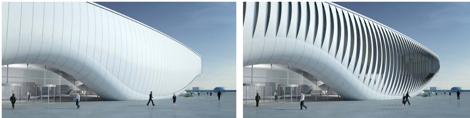
Εικόνα 69. Το μεταβαλλόμενο σύστημα σκίασης του One Ocean, Thematic Pavilion
