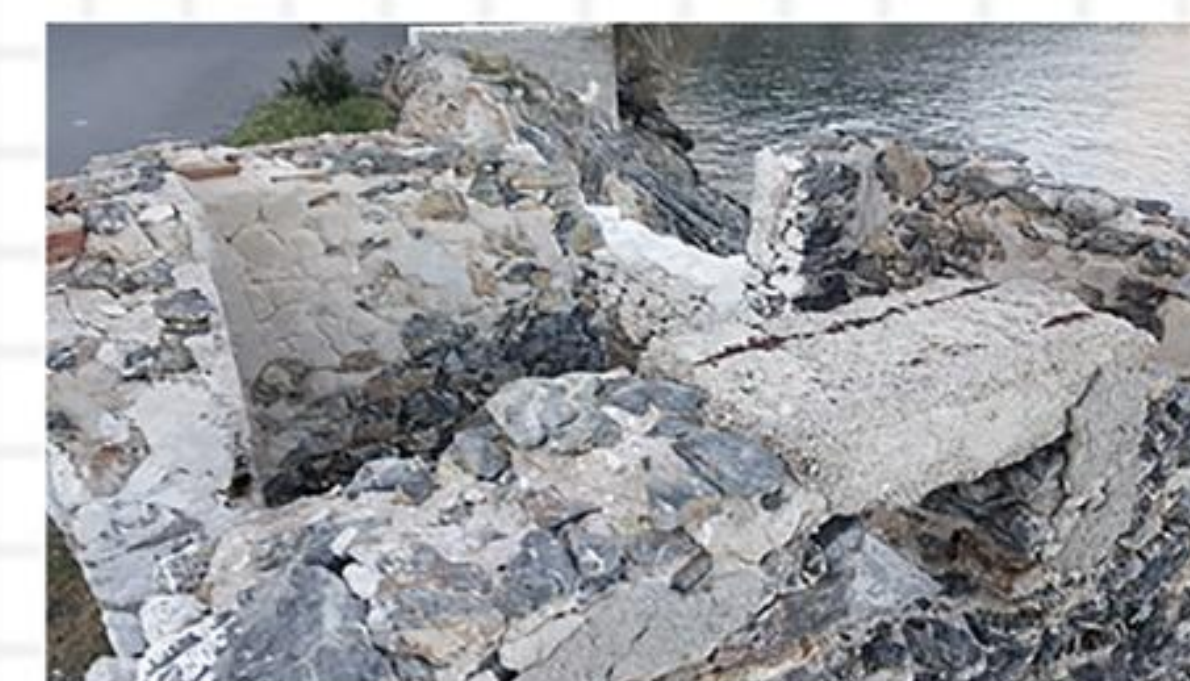
Κατάρρευση και εμφάνιση της λιθοδομής
