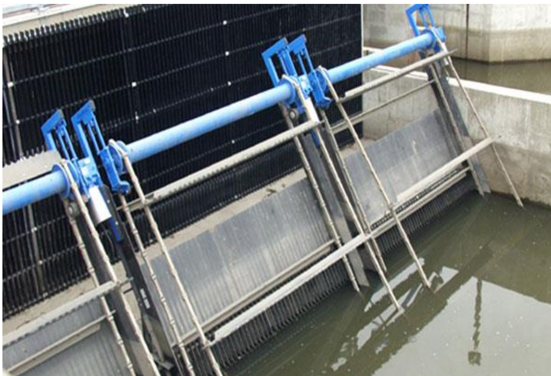
Εικόνα 1.2 Μηχανική σχάρα.
