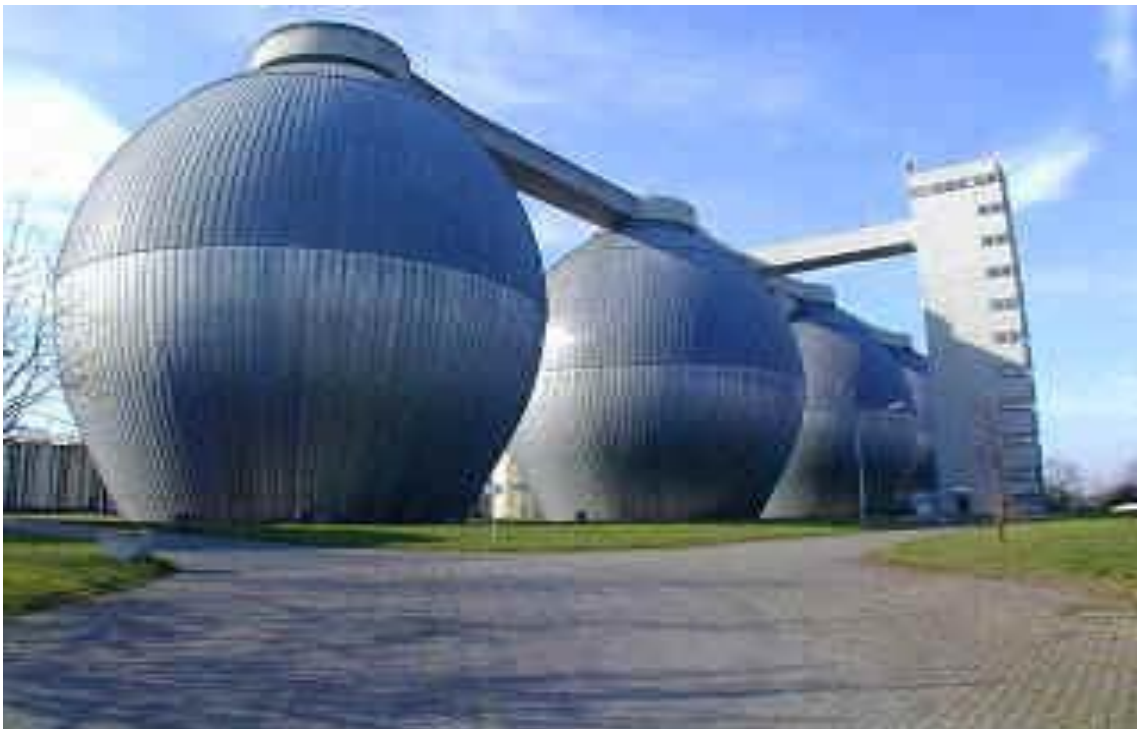
Εικόνα 1.11 Εγκαταστάσεις αναερόβιας χώνευσης ωσειδούς τύπου, Γερμανία. (Πηγή: Σημειώσεις μαθήματος Σχεδιασμός Περιβαλλοντικών Εγκαταστάσεων και Εκτίμηση Περιβαλλοντικών Επιπτώσεων II, Πολυτεχνείο Κρήτης, Τμήμα Μηχανικών Περιβάλλοντος)
