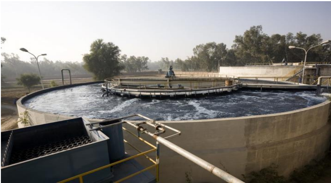
Εικόνα 1.3 Δεξαμενή δευτεροβάθμιας καθίζησης.
