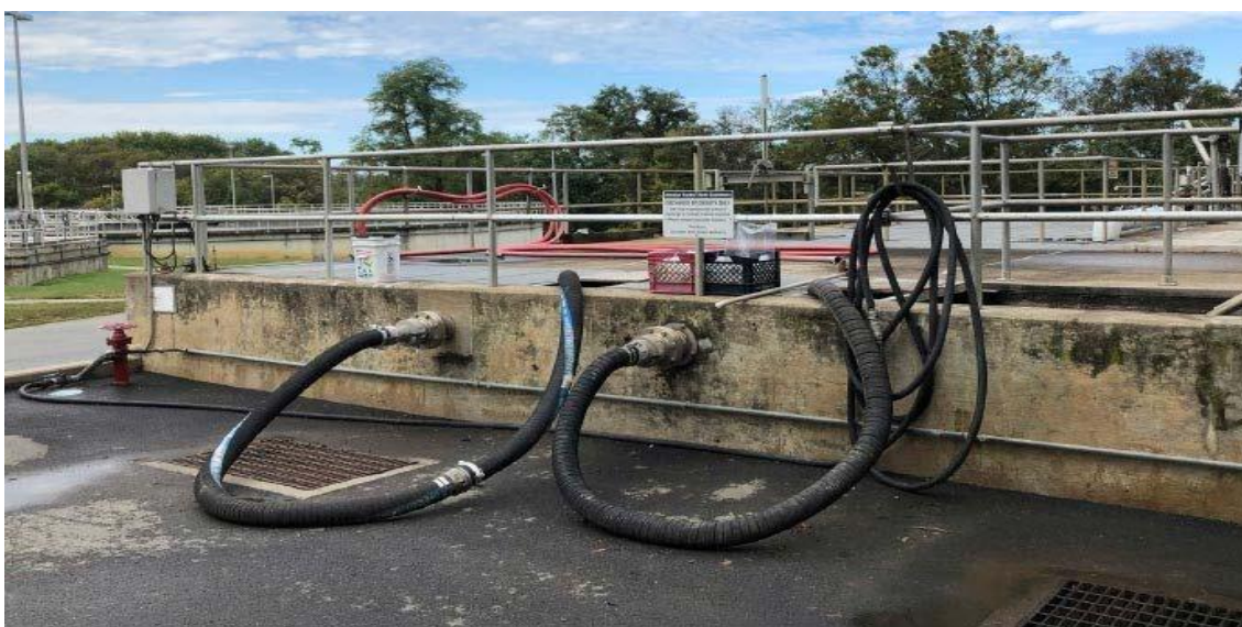
Εικόνα 1.1 Δεξαμενή υποδοχής βοθρολυμάτων.
