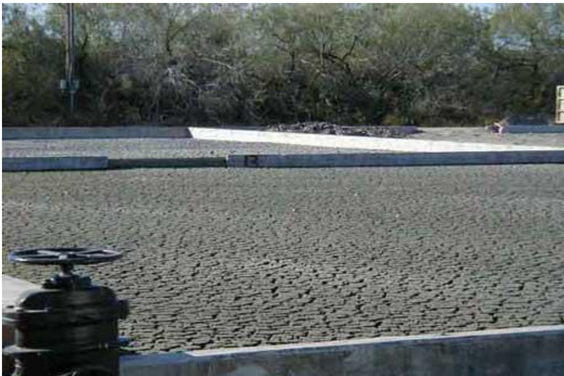
Εικόνα 1.13 Κλίνες ξήρανσης.
