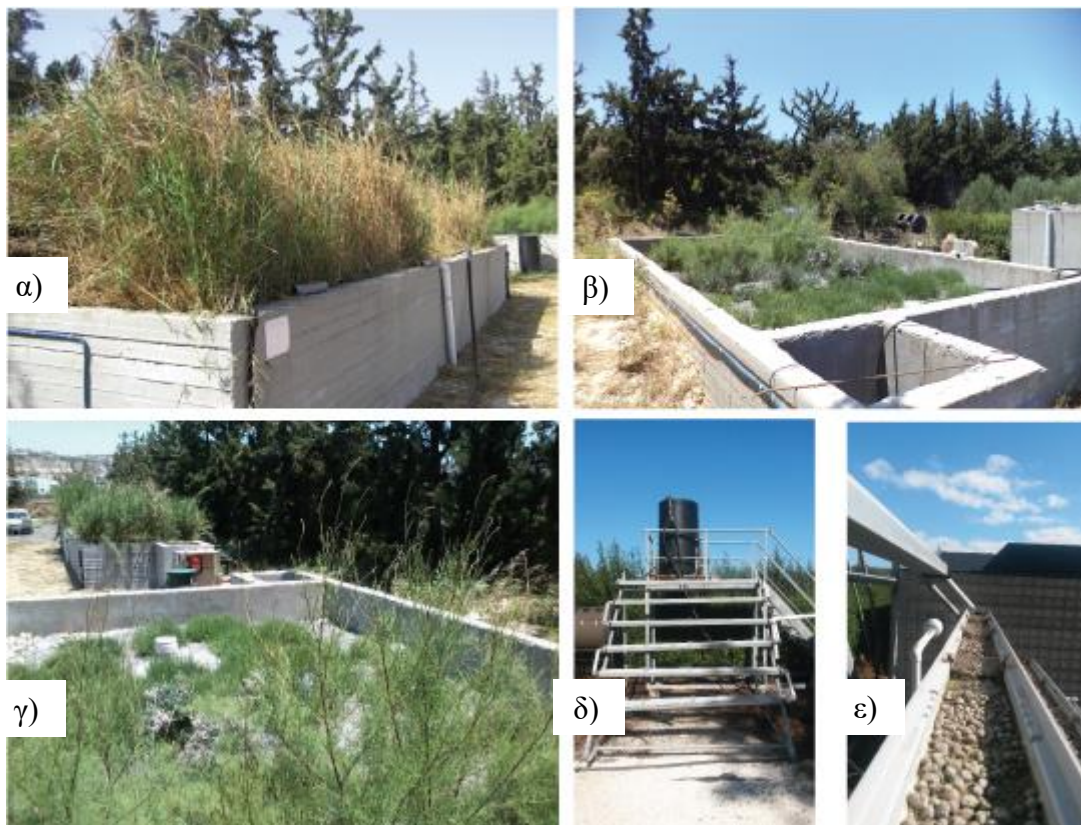
Εικόνα 10. Τεχνητοί υδροβιότοποι συστήματος: α) υδροβιότοπος ελεύθερης επιφάνειας (FWS), β) υδροβιότοπος υποεπιφανειακής ροής (HSSF), γ) υδροβιότοποι FWS και HSSF, δ) αμμόφιλτρο (SF) μαζί με τη μονάδα αδρανοποίηση (IU), ε) κανάλι μονάδας IU.
