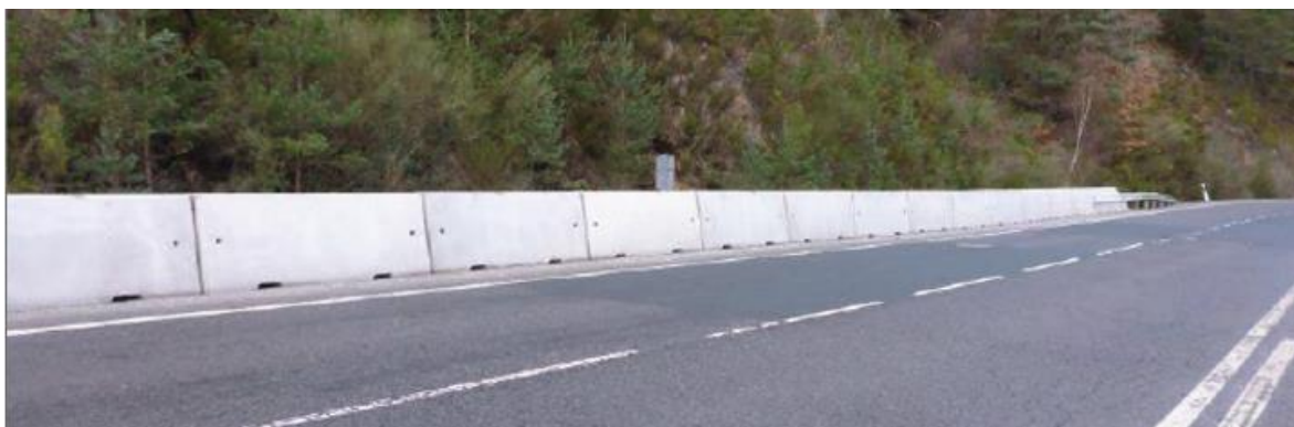
Εικόνα 1.12: Προκατασκευασμένα στηθαία ασφαλείας από σκυρόδεμα [12]
