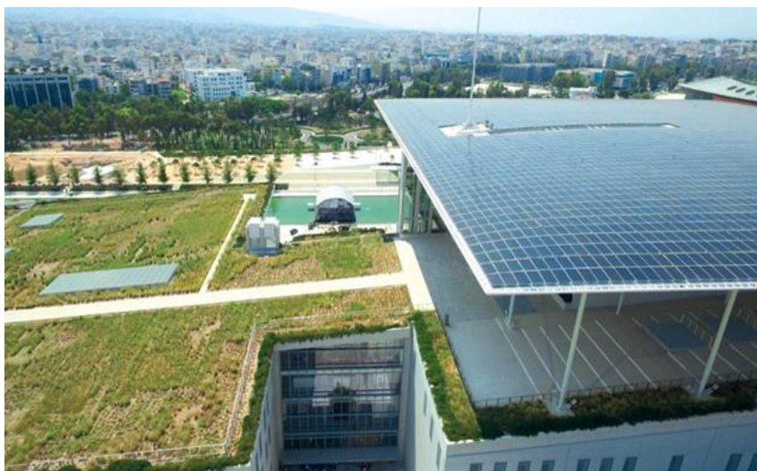
Εικόνα 1-3: Φωτοβολταϊκό στέγαστρο (ονομαστικής ισχύος 1,58 MWp) πάνω από το κτίριο της Εθνικής Λυρικής Σκηνής στο Κέντρο Πολιτισμού Ίδρυμα Σταυρός Νιάρχος.
