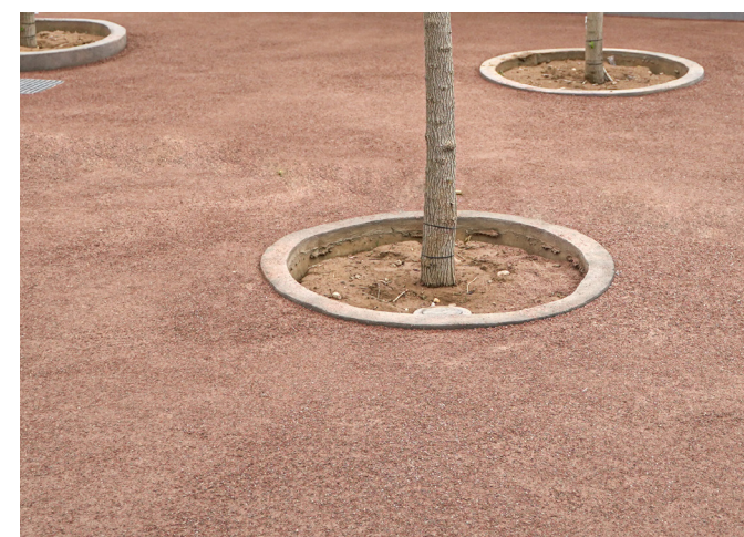
σταθεροποιημένο κεραμικό δάπεδο
