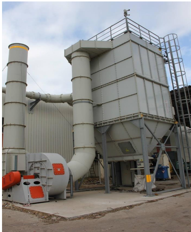
Εικόνα 3.18: Σακόφιλτρο αποκονίωσης Μηχανικής Διαλογής.
