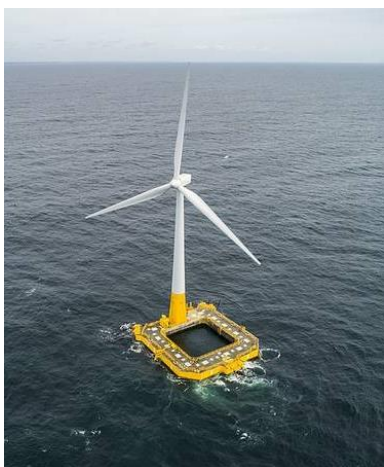
1.8: Πλατφόρμα τύπου φορτηγίδας (Barge) (OE Digital)
