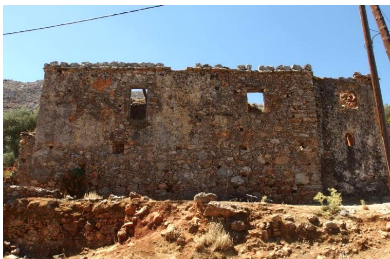
Εικόνα 46: Εναπομένον επίχρισμα της βόρειας όψης.
