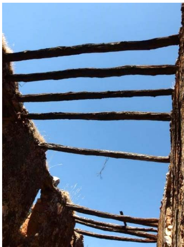
Εικόνα 22: Απομένουσες δοκοί του δώματος.
