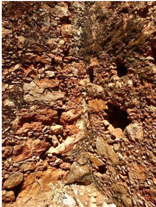
Εικόνα 31: Λεπτομέρεια στη συμβολή τοιχοποιίας δυτικής πλευράς με βόρειας. Διακρίνεται η κατακόρυφη ρηγματώση λόγω μη σύνδεσης των δύο τοιχοποιιών.
