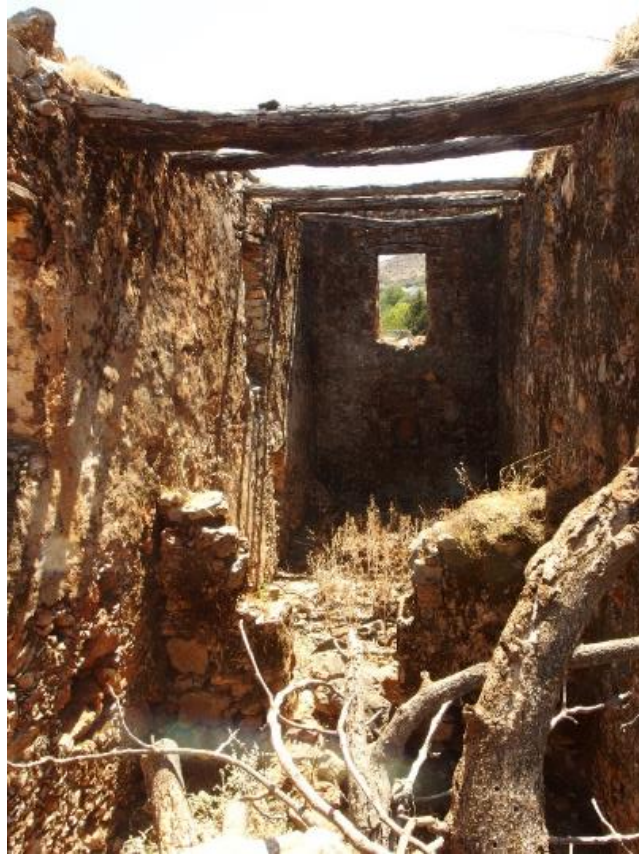
Εικόνα 40: Φθορά και απώλεια ξύλινων στοιχείων του δώματος και του μεσοπατώματος.
