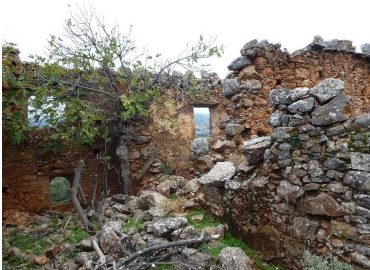
Εικόνα 29: Δυτική όψη - Σφηνοειδής κατάρρευση τοιχοποιίας.
