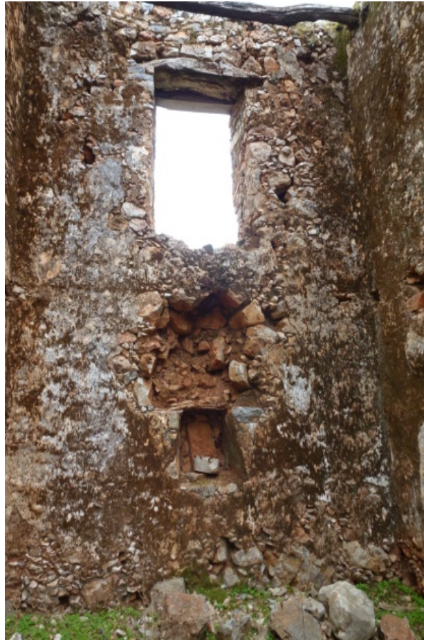
Εικόνα 33: Τοπική απώλεια λίθων - εσωτερική όψη ανατολικής τοιχοποιίας και ρηγματώσεις,
