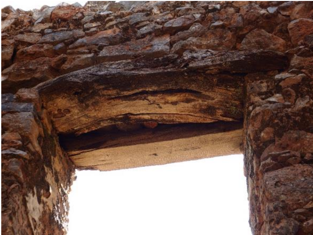
Εικόνα 41: Λεπτομέρεια ξύλινου ανωφλιού της νότιας τοιχοποιίας.
