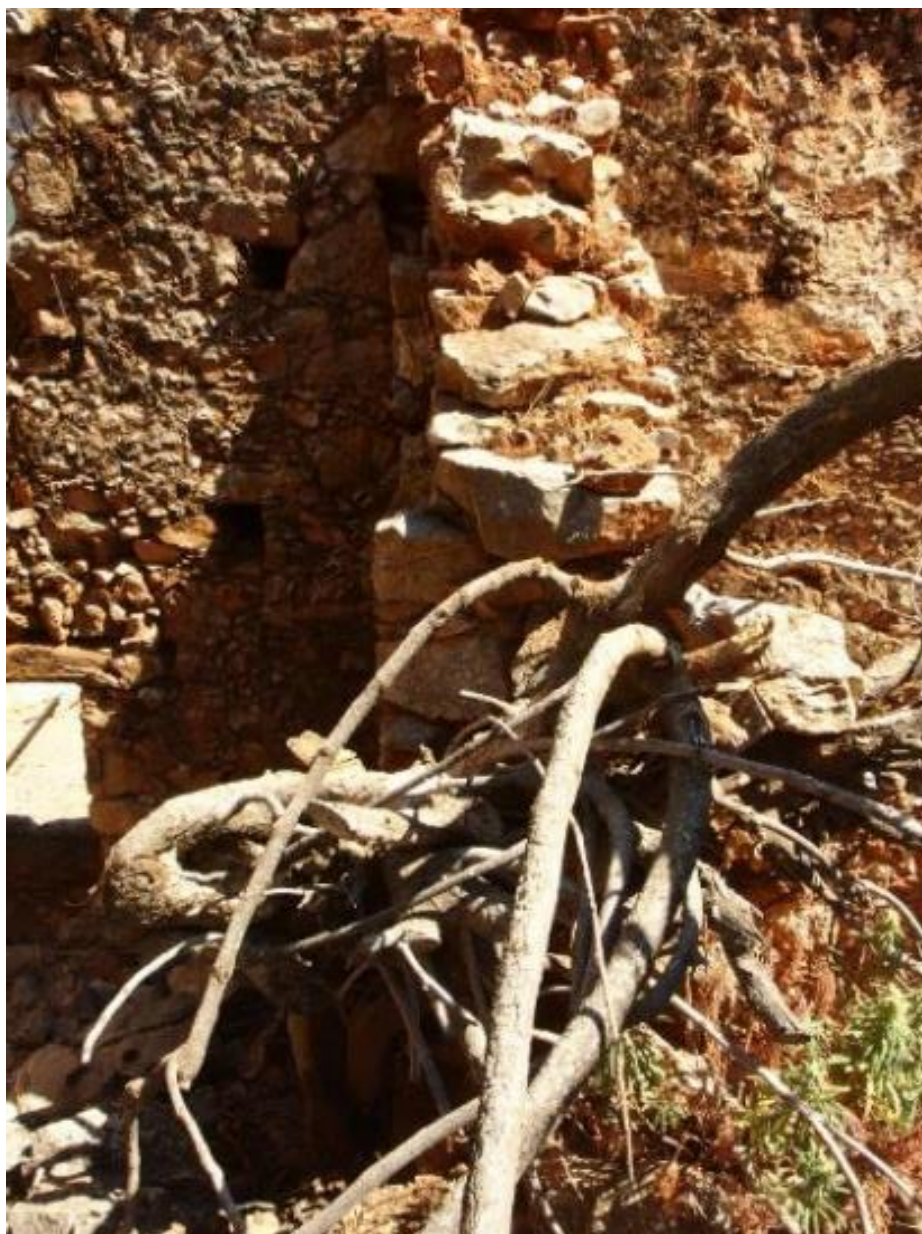
Εικόνα 39: Αποδιοργάνωση της δυτικής τοιχοποιίας από την ανάπτυξη αυτοφυούς συκιάς.
