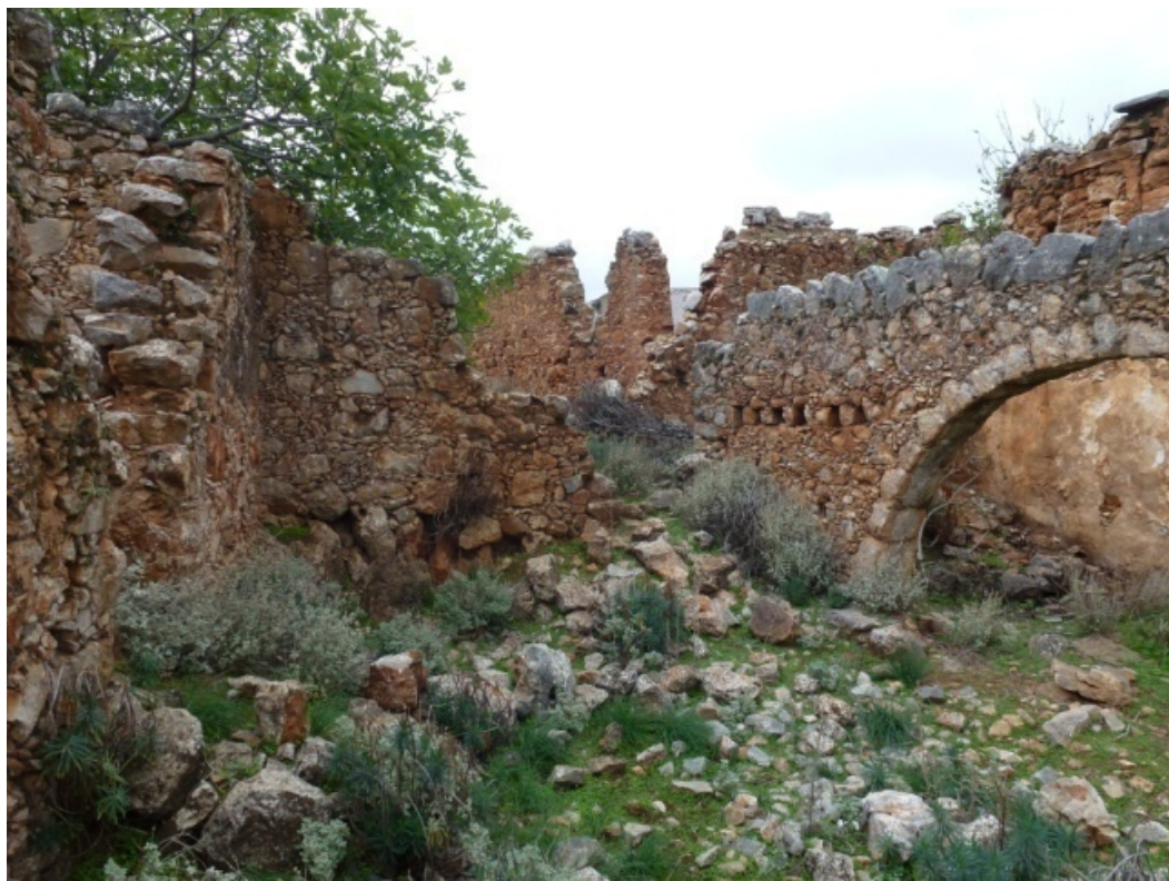
Εικόνα 36: Αποδιοργάνωση λίθων στη δυτική πλευρά του κτιρίου.
