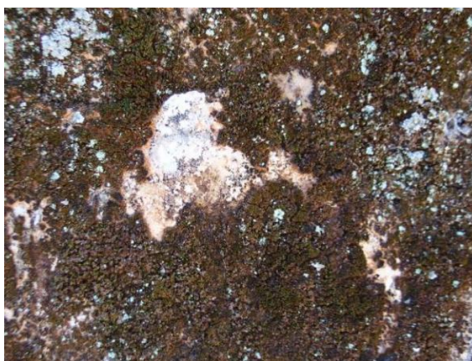
Εικόνα 38: Ανάπτυξη βρύων και λειχήνων στην τοιχοποιία.
