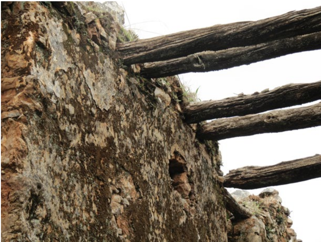
Εικόνα 35: Τοπική απώλεια λίθων στη στέψη.
