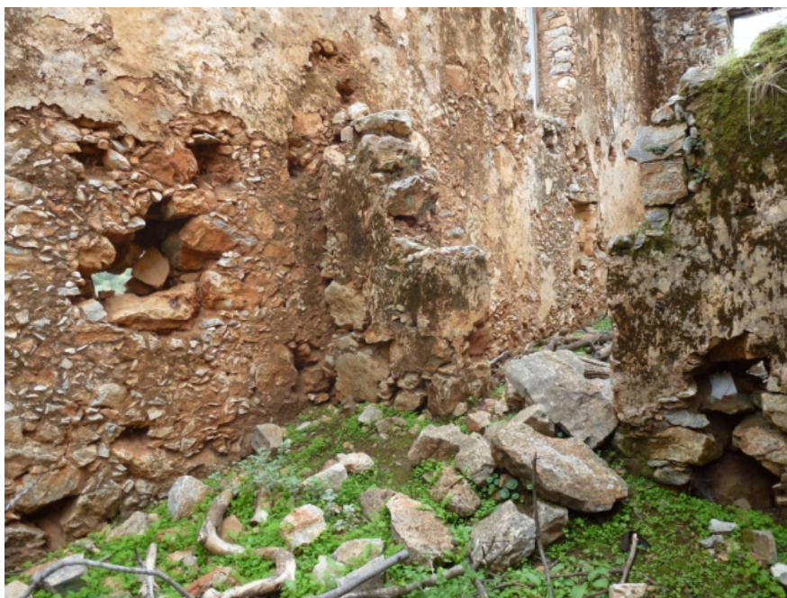
Εικόνα 37: Αποδιοργάνωση λίθων στην ενδιάμεση λιθοδομή του ισογείου.
