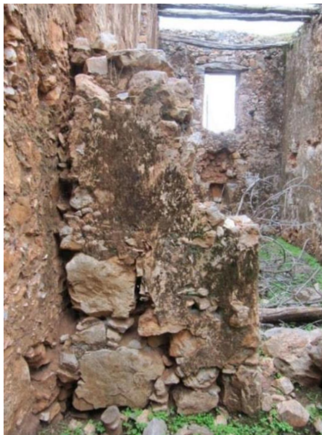
Εικόνα 32: Αποκόλληση της εσωτερικής τοιχοποιίας από τη βόρεια.
