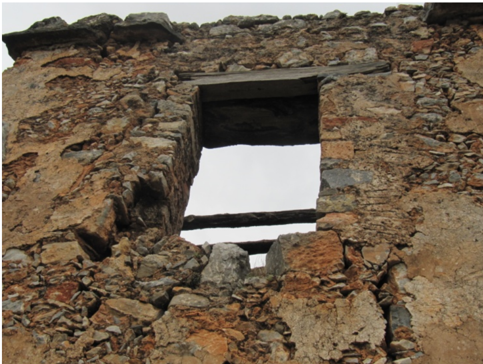
Εικόνα 34: Τοπική απώλεια λίθων περιμετρικά των ανοιγμάτων στην εξωτερική όψη.
