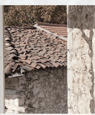
Επικάλυψη στέγης με κεραμίδια βυζαντινού τύπου σε κακή κατάσταση
