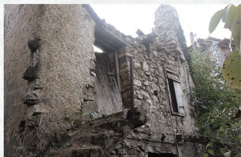
Ξύλινα κουφώματα σε κακή κατάσταση
