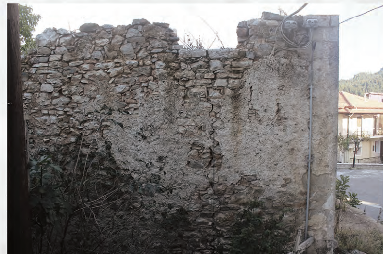
Ρηγμάτωση τοιχοποιίας
