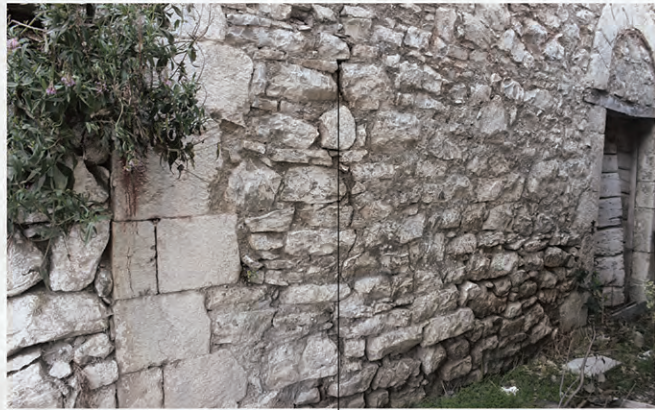
Ρηγμάτωση τοιχοποιίας
