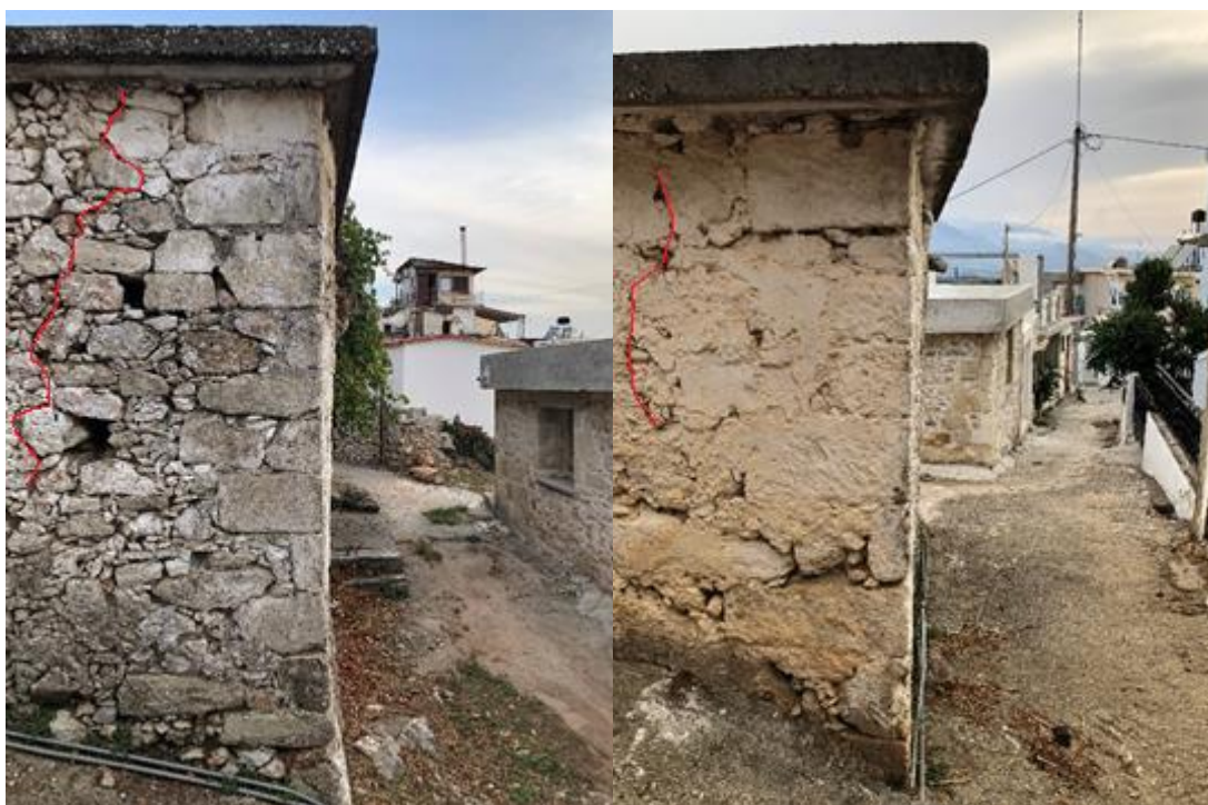
Εικόνα 7.3.4. Εκτός επιπέδου λειτουργία στις γωνίες του κτιρίου
