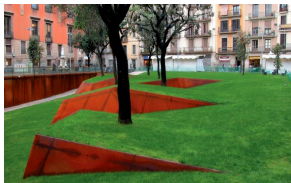
Εικόνα 174: Η διατήρηση της στάθμης των δέντρων με τεχνητά αναχώματα. Πηγή: todosobrebarcelona.com/wp-content/uploads/2016/11/VILLA-im06.jpg
