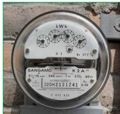
Εικόνα 111. Αναλογικός μετρητής ενέργειας [90]
