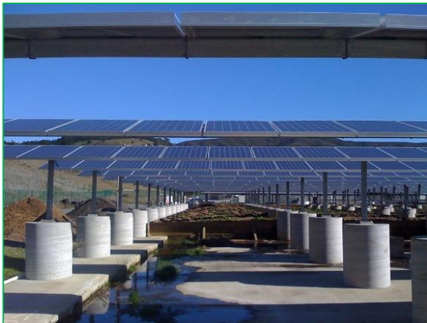
Εικόνα 104. Σταθερά συστήματα στήριξης Φ/Β στην οροφή εγκατάστασης διαχείρισης αποβλήτων (Pacifica, ΗΠΑ)
