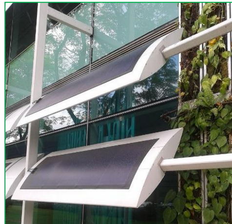
Εικόνα 105. Φ/Β πάνελ σαν μέθοδος εξωτερικής σκίασης σε κτίριο "μηδενικής ενέργειας", Σιγκαπούρη
