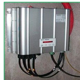
Εικόνα 108. Inverter Φ/Β συστήματος on grid/grid tie [87]
