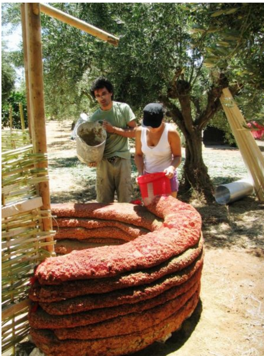
Εικ. 59: Γέμισμα και ευθυγράμμιση των στρωμάτων
