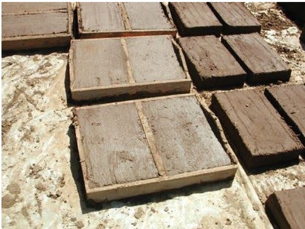
Εικ.10: καλούπια για το σχηματισμό συμπιεσμένων πλίνθων
