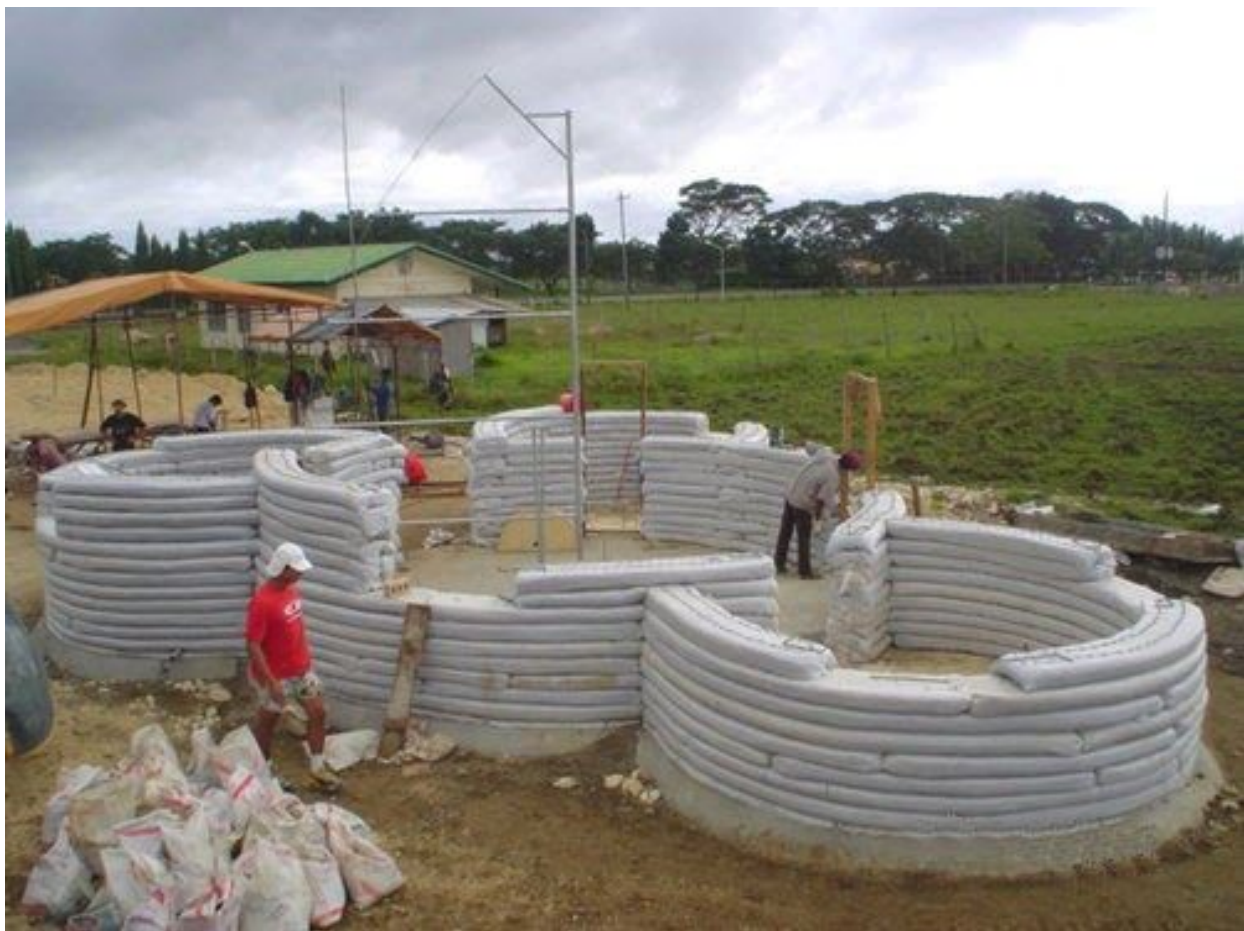
Εικ. 51: μέθοδος δόμησης με γαιόσακους
