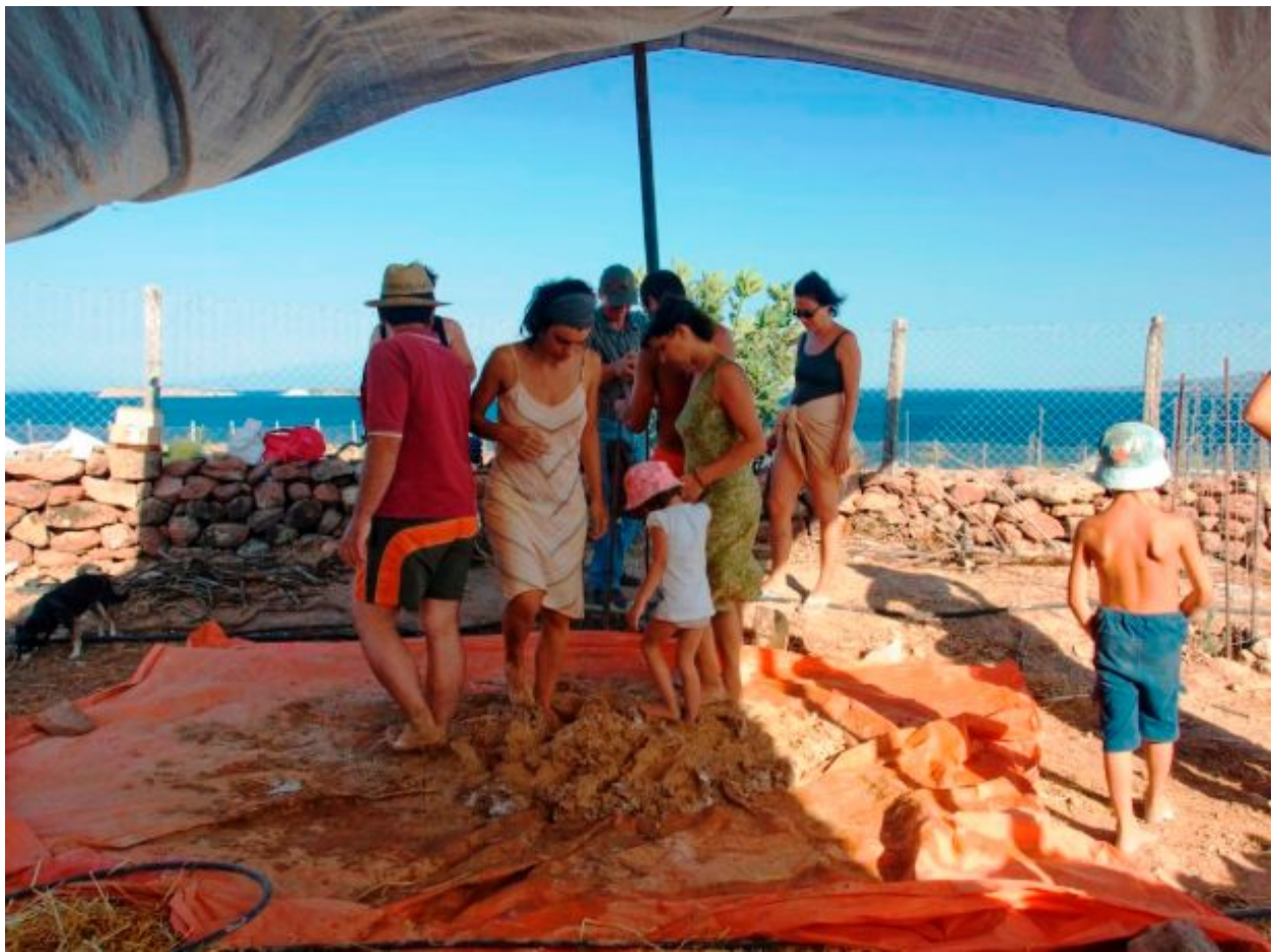
Εικ.14: δημιουργία μείγματος από πηλό, άμμο και άχυρο
