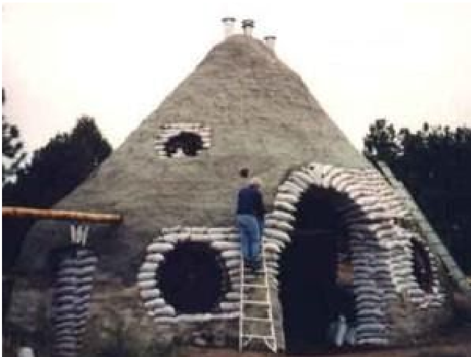
Εικ.56, 57: κατασκευαστικές φάσεις με τη μέθοδο Hyperadobe
