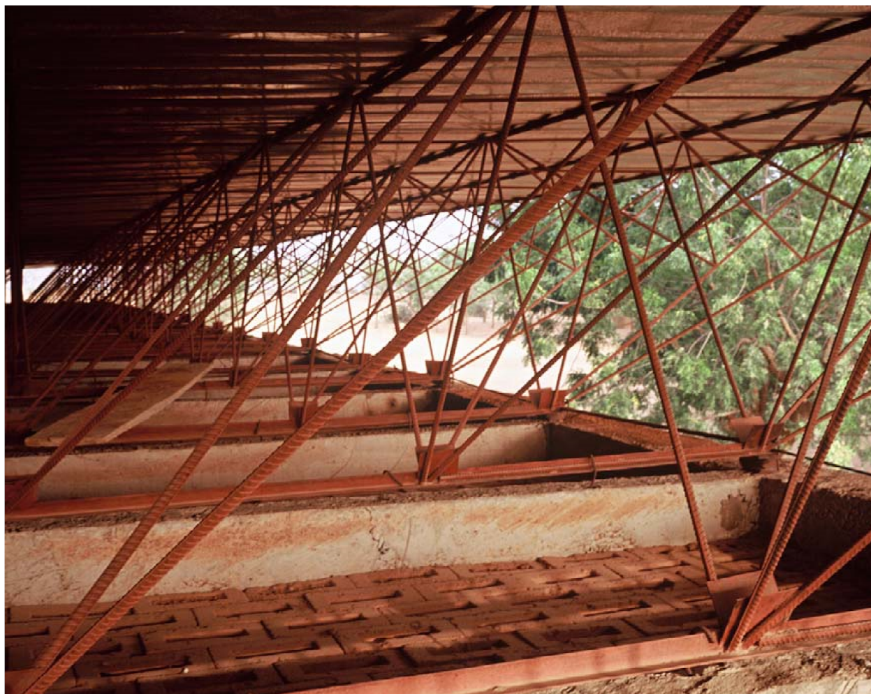
Εικ.94: Λεπτομέρεια χωροδικτυώματος οροφής
