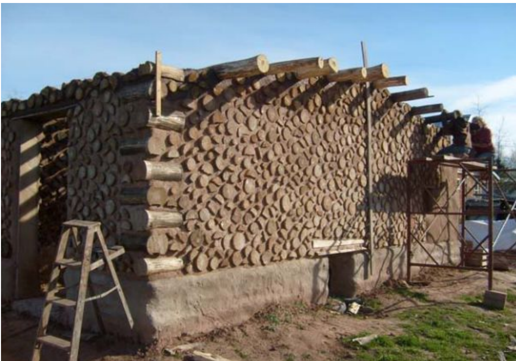
Εικ. 26, 27: φάσεις κατασκευής με καυσόξυλα
