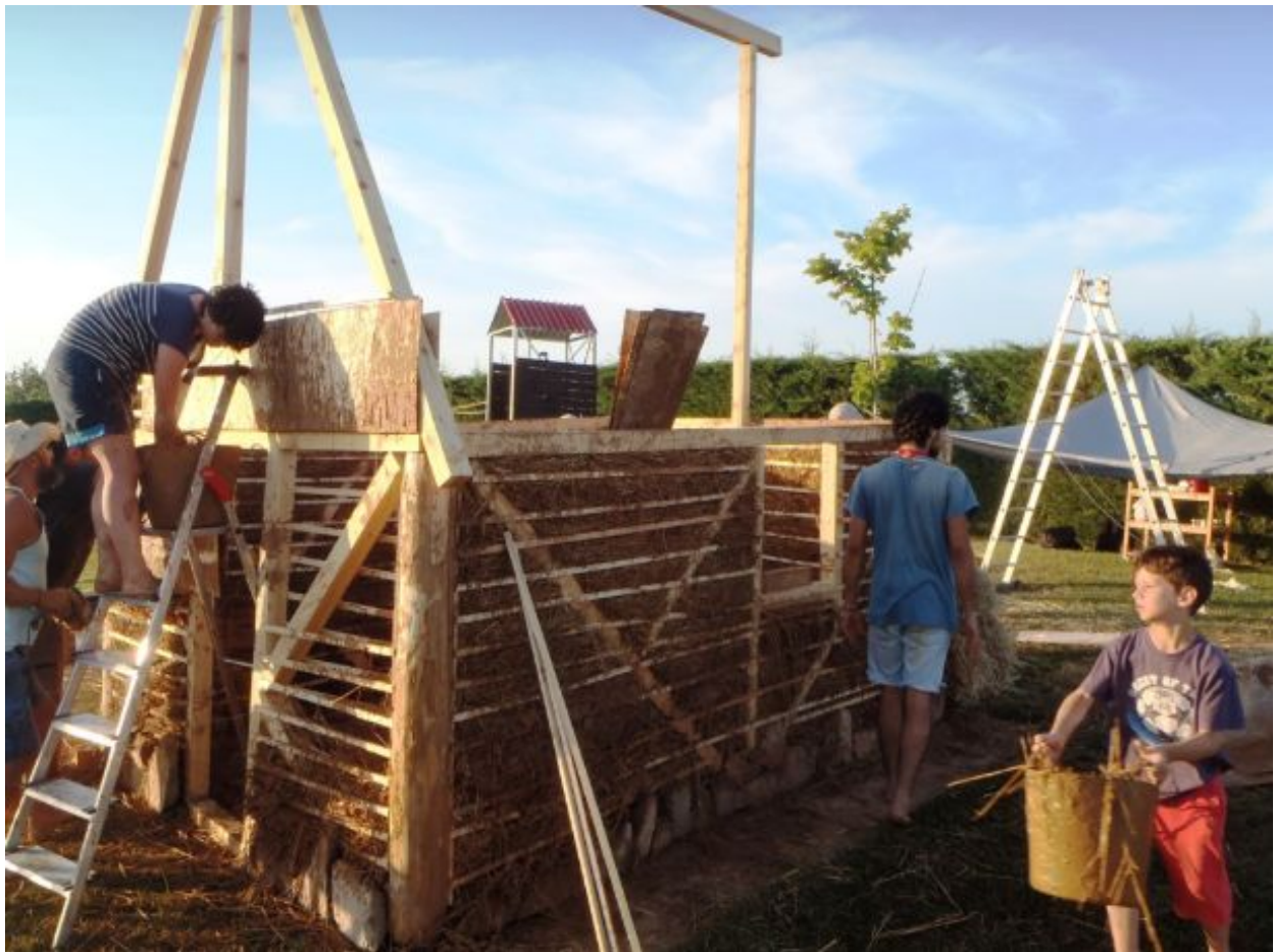
Εικ. 46: εφαρμογή άχυρου με πηλό στην κατασκευή
