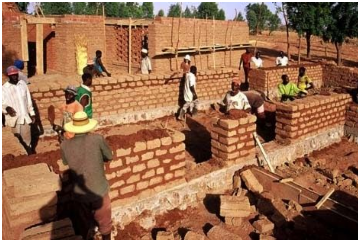
Εικ. 70: διαδικασία κατασκευής τοιχοποιίας με τούβλα από λάσπη
