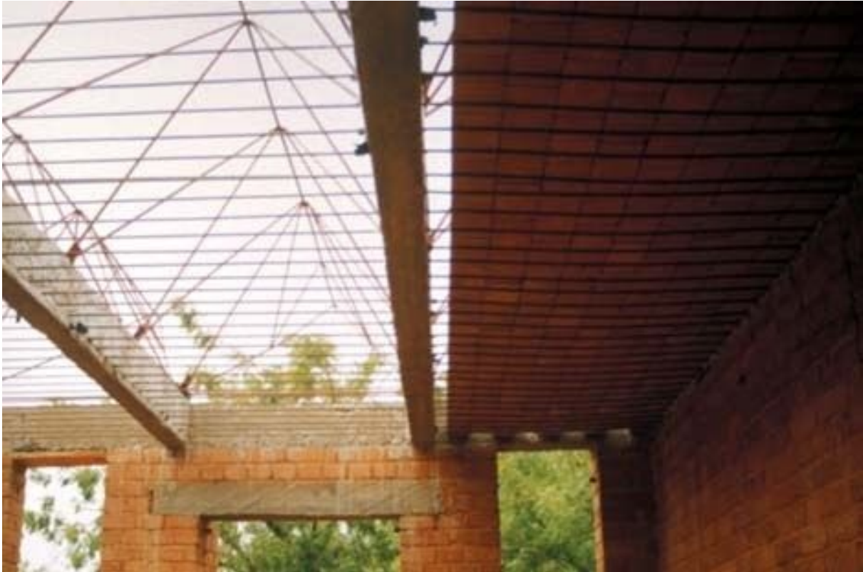
Εικ.90: τοιχοποιίες από πλινθία και χρήση οπλισμένου σκυροδέματος
