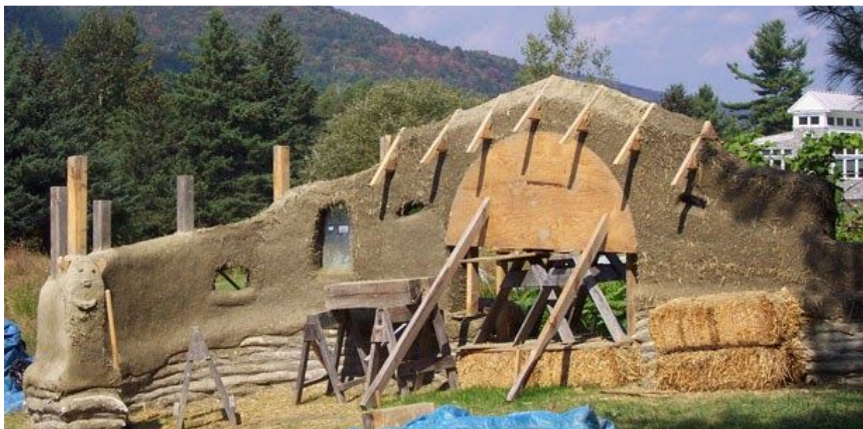
Εικ. 24: τεχνική φυσικής δόμησης από cob
