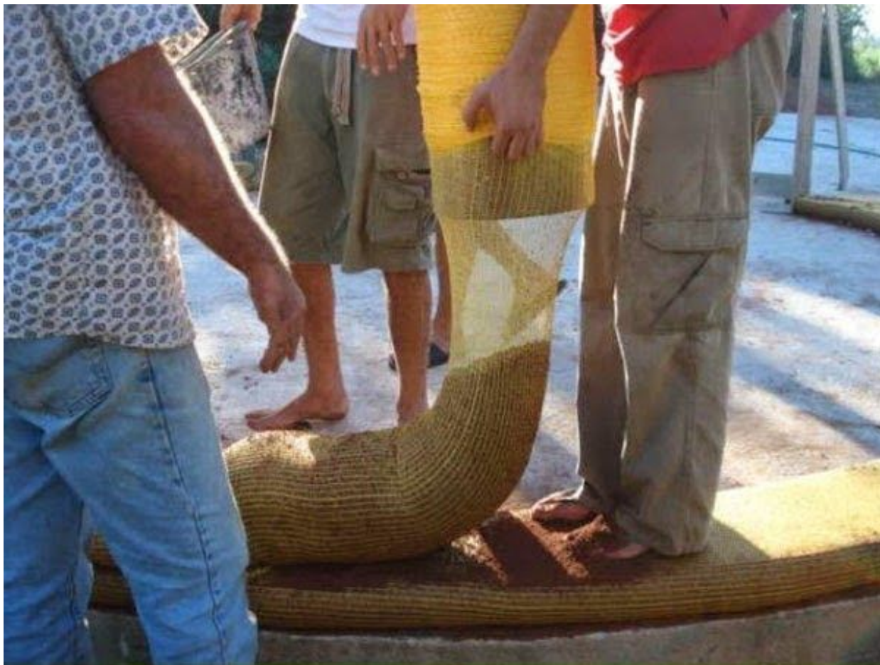
Εικ. 58: διαδικασία τοποθέτησης χώματος στο δικτυωτό σωλήνα
