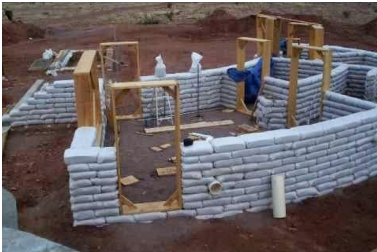
Εικ.60: εξ αρχής τοποθέτηση πορτών και παραθύρων
