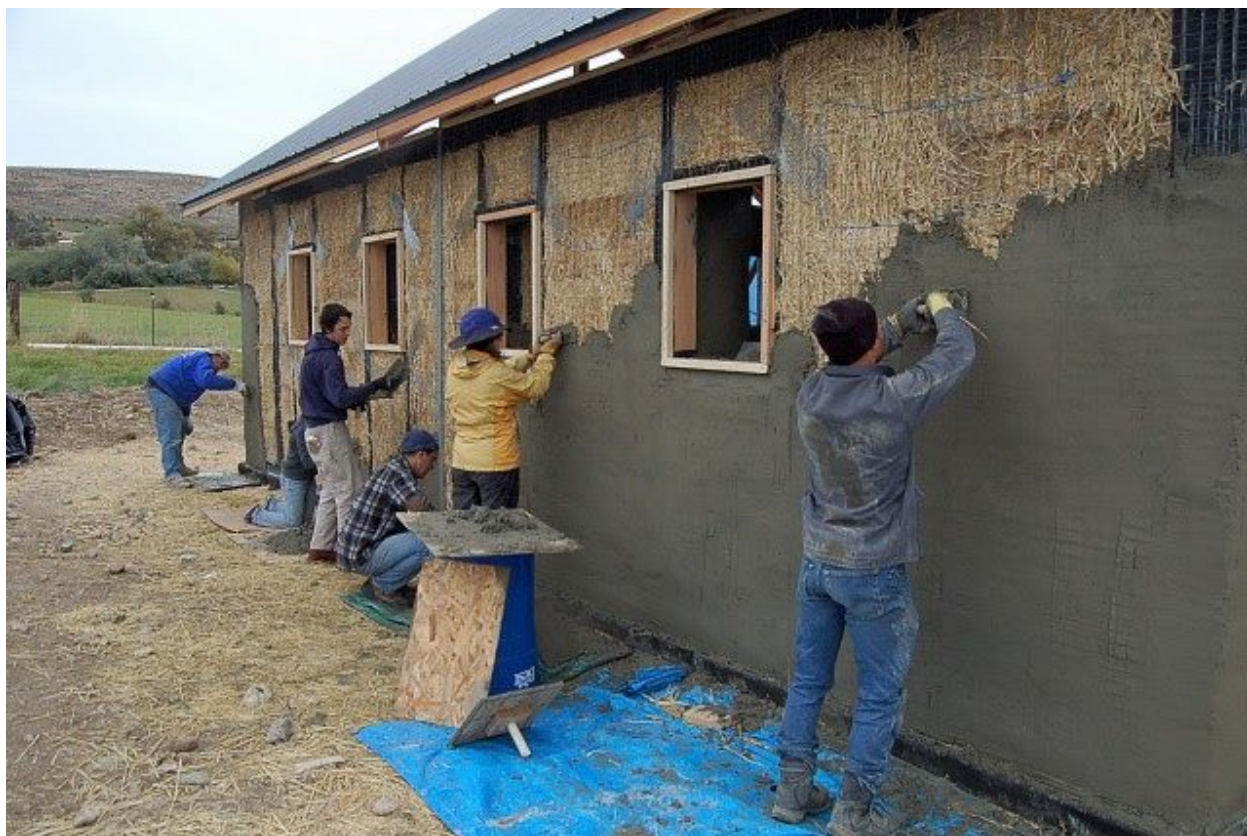
Εικ.43: επιχρίσματα εξωτερικά των τοιχοποιιών από άχυρο
