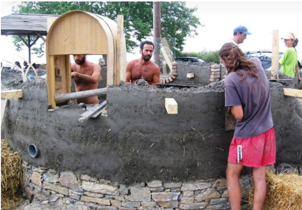
Εικ.18, 19: φάσεις κατασκευής κτίσματος από cob
