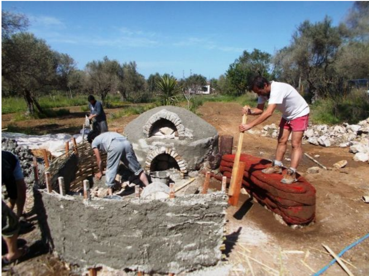
Εικ.53: διαδικασία κατασκευής με γαιόσακους
