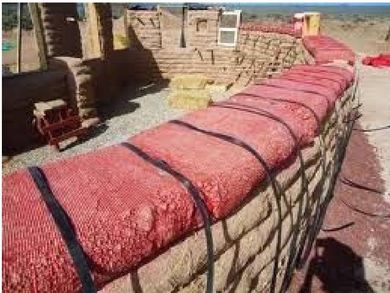
Εικ.54: διαδοχικά στρώματα γαιόσακων
