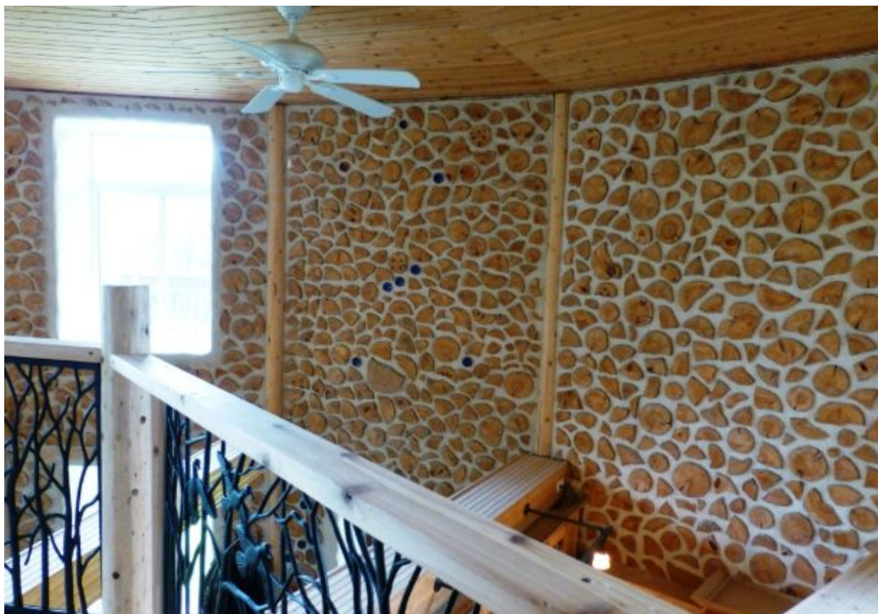
Εικ. 28: εσωτερική άποψη της φυσικής μεθόδου κατασκευής με cordwood
