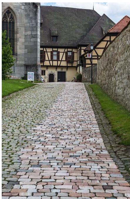
Εικ. 183 Αντικατάσταση του παλαιού πλακόστρωτου με νέο (Μοναστήρι στην πόλη Tübingen)
