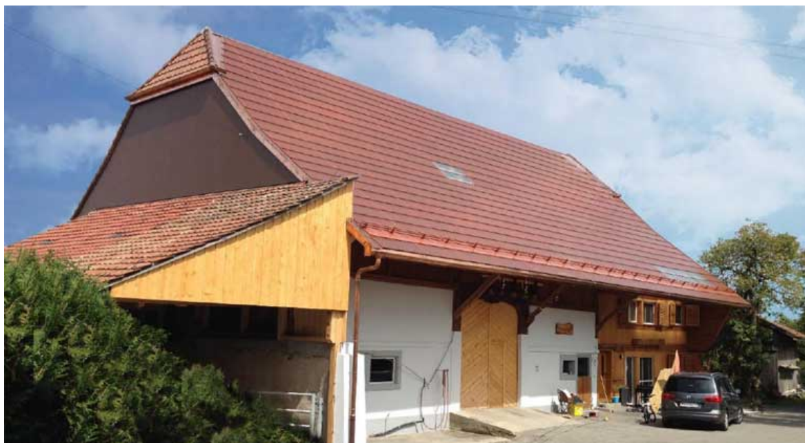
Εικ. 191 Τοποθέτηση φωτοβολταϊκών κεραμιδιών σε κτίριο της προστατευόμενης πόλης, Freiburg της Ελβετίας
