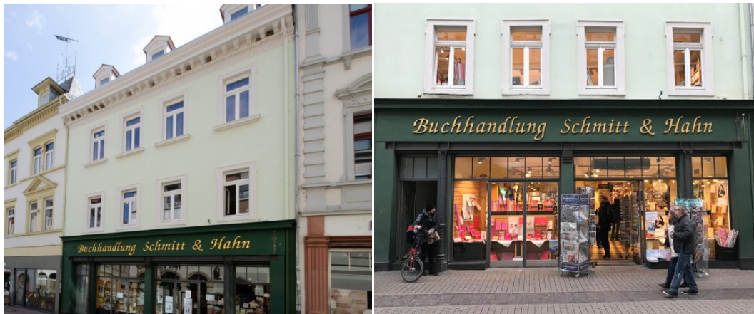
Εικ. 190 Κτίριο επί της οδού Hauptstraße, με εμφανή τη μεταλλική ενίσχυση στο ισόγειο
