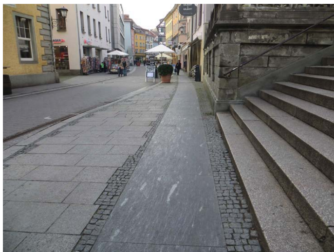
Εικ. 182 Τοποθέτηση μεγάλων ενιαίων πλακών στο πεζοδρόμιο (παράδειγμα από την πόλη Überlingen)
