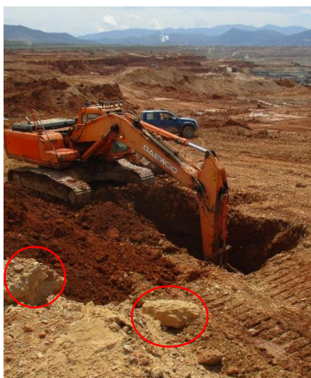
Σχήμα 4.12: Τοποθέτηση σκληρών σχηματισμών στη βαθμίδα
