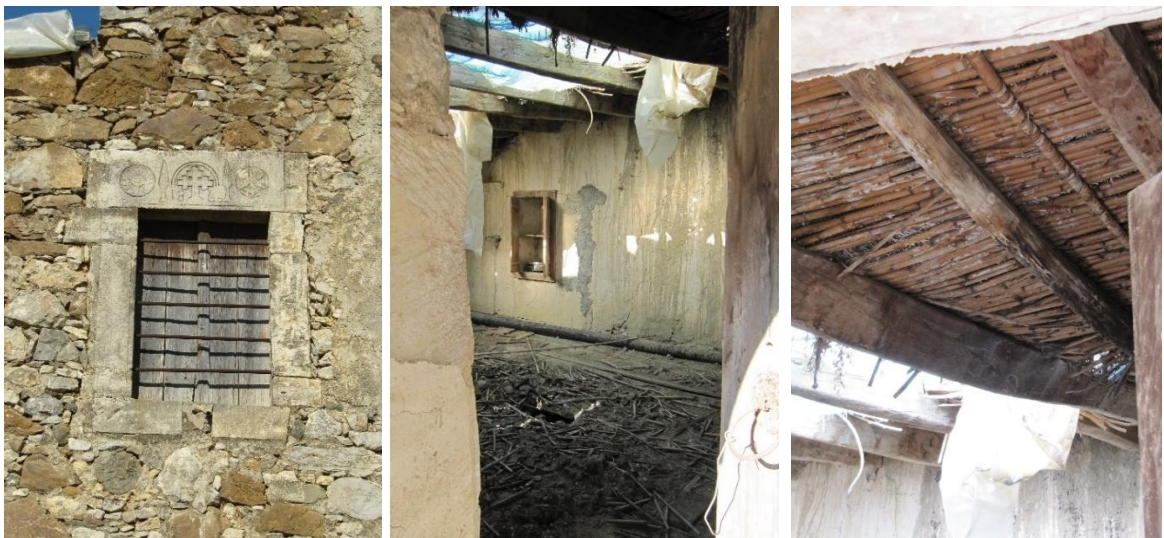
Εικ.57. Αριστερά: Λεπτομέρεια ανοίγματος. Κέντρο: Διακρίνονται τα ξύλινα δοκάρια, και τα υπόλοιπα κατασκευαστικά υλικά της στέγης (καλάμια και φιαλώματα) που έχουν καταρρεύσει. Δεξιά: Λεπτομέρεια των κατασκευαστικών στοιχείων της στέγης. Διακρίνονται τα ξύλινα δοκάρια, τα καλάμια και τα φιαλώματα. (Πηγή: προσωπικό αρχείο)
