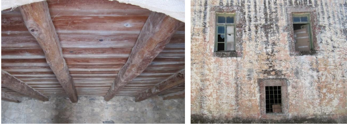
Εικ.61. Αριστερά: Λεπτομέρεια της δομής του εσωτερικού δαπέδου του κτίσματος από το χαμηλό άνοιγμα του βορινού τοίχου. Δεξιά: Λεπτομέρεια του βορινού τοίχου και της τυπολογίας των ανοιγμάτων του. (Πηγή: προσωπικό αρχείο)
