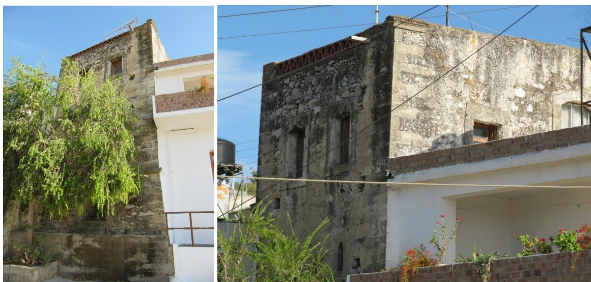
Εικ.54. Απόψεις του Πάνω Πύργου των Κουρμούληδων στο κέντρο του χωριού, όπου διακρίνεται η τυπολογία των ανοιγμάτων και μερικές από τις αλλοιώσεις στην στέγη. (Πηγή: προσωπικό αρχείο)
