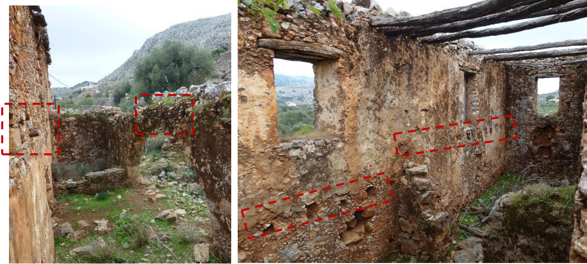
Εικ.96. Οι δοκοθήκες, καθώς δεν έχουν σωθεί καθόλου ξύλινα δοκάρια πατωμάτων στην οικία Σεϊμένη, παρά μόνο ελάχιστα του δώματος. (Πηγή: προσωπικό αρχείο)
