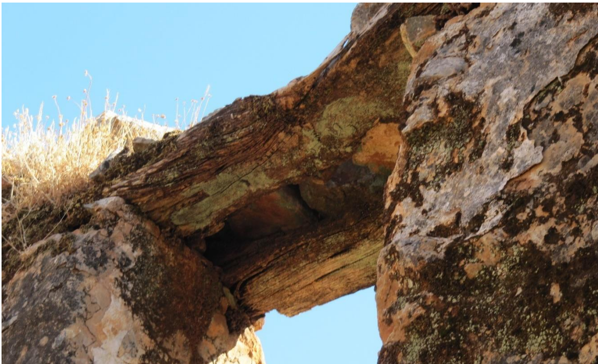
Εικ.112. Πρέκι ανοίγματος ορόφου οικίας Σεϊμένη. (Πηγή: προσωπικό αρχείο)
