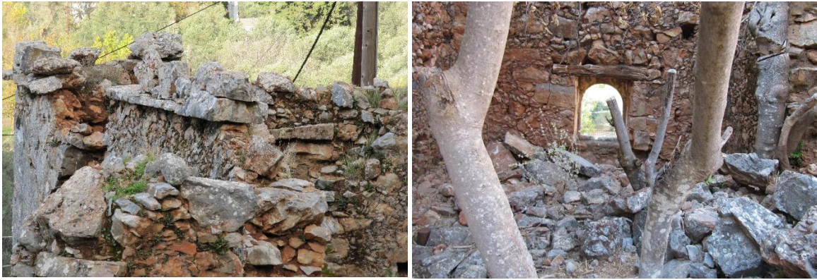
Εικ.81. Αριστερά: Ο εναπομείναντας βορειοδυτικός τοίχος έχει μια κλίση άνω των 30° προς το εσωτερικό. Δεξιά: Στο εσωτερικό της κατοικίας έχει καταρρεύσει μεγάλο μέρος των κατασκευαστικών της στοιχείων (πέτρες, χώμα από την στέγη). (Πηγή: προσωπικό αρχείο)
