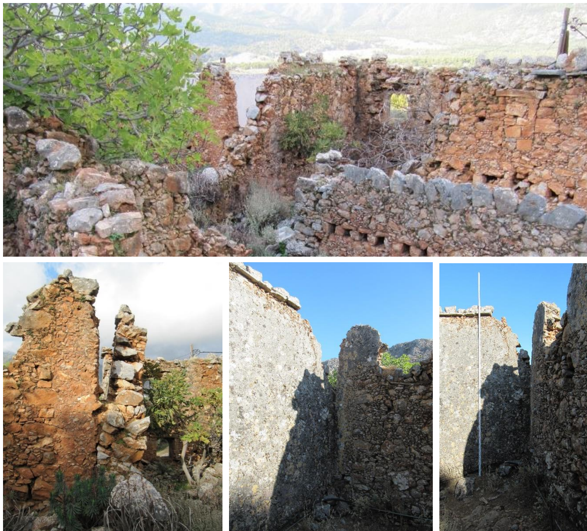
Εικ.108. Τοιχοποιία με έντονη κλίση στην ενετική κατοικία. Άποψη από την εσωτερική και εξωτερική μεριά. (Πηγή: προσωπικό αρχείο)
