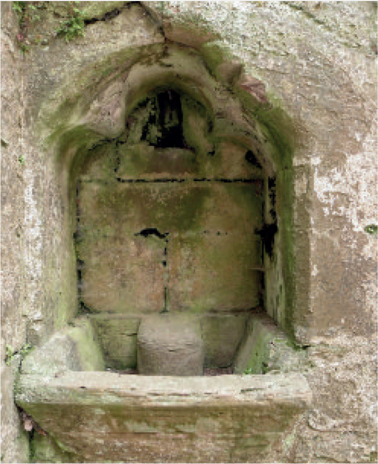
Νιπτήρας με παροχή νερού από το πηγάδι της αυλής μέσω υδροσωλήνα, καστρο Goodrich
