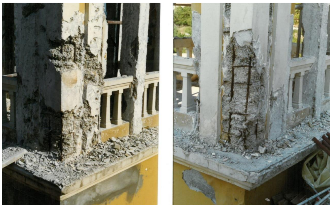
Εικόνα 95: Διάβρωση σιδηροπλισμού και ζωonoποίηση αδρανών στο κωδωνοστάσιο του Ι.Ν. της Αγ. Παρασκευής στις Καλύβες. Πηγή: Αρχείο Ι.Ν. της Αγ. Παρασκευής στις Καλύβες
