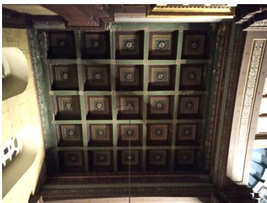
Εικόνα 49: Δοκιδωτή πλάκα γωνιακού διαμερίσματος (Αριστερά) και γυναικωνίτης (Δεξιά) του Ι.Ν. της Ευαγγελίστριας στη Χαλέπα
