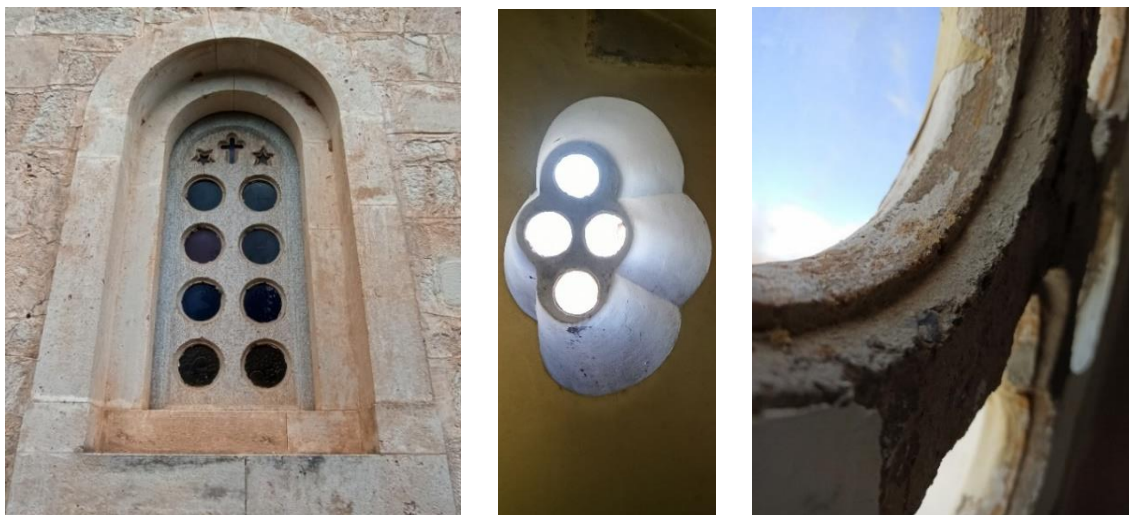
Εικόνα 35: Τσιμεντένιο διάφραγμα ανοίγματος από τον Ι.Ν. του Αγ. Νικολάου στους Αρμένους (Δεξιά). – Τσιμεντένιο διάφραγμα από τον Ι.Ν. του Τιμίου Σταυρού στον Αλικιανό - Τσιμεντένιο διάφραγμα ανοίγματος, υπό επισκευή στον Ι.Ν. του Αγ. Παντελεήμονα στον Φουρνέ.
