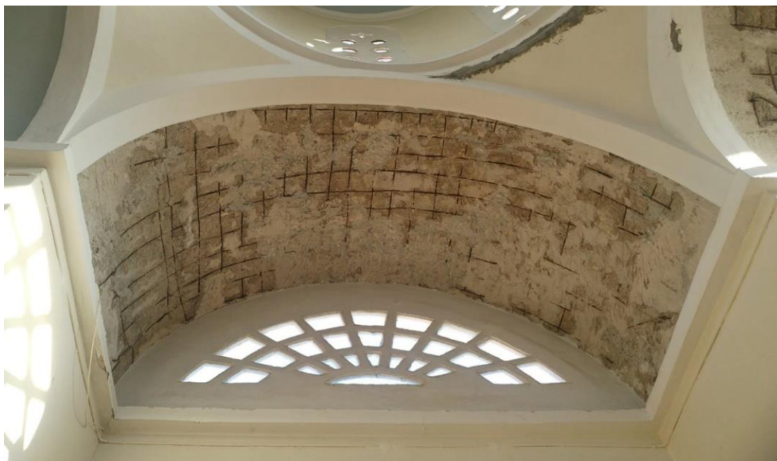
Εικόνα 23: Οπλισμός θόλου του Ι.Ν. του Αγίου Σπυρίδωνος στην περιοχή του Αγίου Ιωάννη στα Χανιά Πηγή: Αρχείο Ιωάννη Παπαγρηγοράκη
