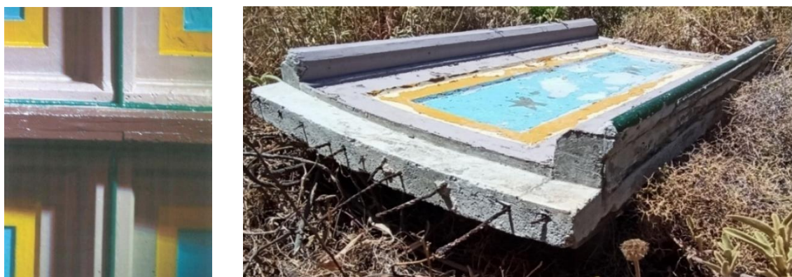
Εικόνα 46: Λεπτομέρεια κόμβου προκατασκευασμένων πλακών του Ι.Ν. της Ευαγγελίστριας στη Χαλέπα (Αριστερά) και αυθεντική προκατασκευασμένη πλάκα, η οποία καθαιρέθηκε κατά τη διαδικασία επισκευών του ναού (Δεξιά).
