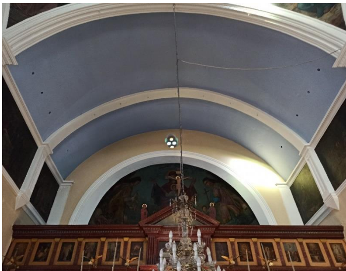
Εικόνα 67: Τα λαήνια που είναι τοποθετημένα στον ανατολικό θόλο του Ι.Ν. του Τιμίου Σταυρού στον Αλικιανό (Αριστερά). - Οπή λαηνιού (Δεξιά).
