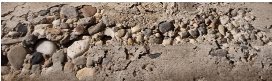
Εικόνα 19: Μη θραυστά αδρανή στο σκυρόδεμα στον Ι.Ν. του Αγ. Νικολάου στους Αρμένους
