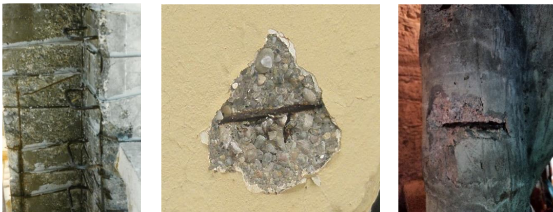
Εικόνα 20: Διάβρωση οπλισμού και απομίξεις αδρανών στο κωδωνοστάσιο του Ι.Ν. της Αγ. Παρασκευής στις Καλύβες (Αριστερά). Πηγή: Αρχείο Ιωάννη Παπαγρηγοράκη - Διάβρωση οπλισμού και απομίξεις αδρανών στην τοιχοποιία του Ι.Ν. της Αγ. Παρασκευής στις Καλύβες (Μέση) - Διάβρωση οπλισμού σε υποστύλωμα της κλίμακας του γυναικωνίτη του Ι.Ν. του Αγ. Νικολάου στους Αρμένους (Δεξιά).
