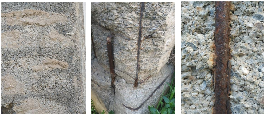
Εικόνα 98: Απόμιξη αδρανών σκυροδέματος (Αριστερά) και οπλισμός υποστυλώματος οπλισμένου σκυροδέματος (Μέση) στην οικία Γαγάνη στη συμβολή Νεάρχου και Γιαμπουδάκη - Διατομές αδρανών σκυροδέματος και σιδηροπλισμός από την οικία Γ. Καρδαμάκη στην Ελευθερίου Βενιζέλου 126 (Δεξιά).
