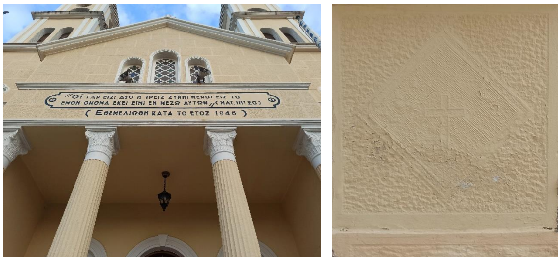
Εικόνα 96: Εφαρμογή τεχνικής αρτιφισιέλ στην πρόσοψη του Ι.Ν. της Αγ. Παρασκευής στις Καλύβες (Αριστερά). – Λεπτομέρεια αρτιφισιέλ από τη βάση του κωδωνοστασίου του Ι.Ν. της Αγ. Παρασκευής στις Καλύβες (Δεξιά).
