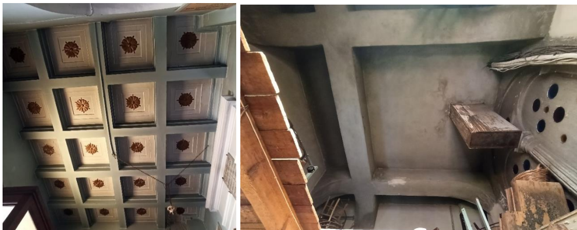
Εικόνα 62: Δοκιδωτή πλάκα του νάρθηκα του Ι.Ν. των Αγ. Κων/νου και Ελένης στη Νέα Χώρα (Αριστερά). - Δοκοί ενίσχυσης δεύτερου επιπέδου κωδωνοστασίου (Δεξιά).
