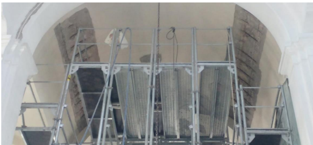
Εικόνα 90: Εσχάρα οπλισμού θόλου μεσαίου κλίτους του Ι.Ν. Αγ. Παντελεήμονα στον Φουρνέ. Πηγή: Αρχείο Ιωάννη Παπαρηγοράκη από τις εργασίες αποκατάστασης του ναού.
