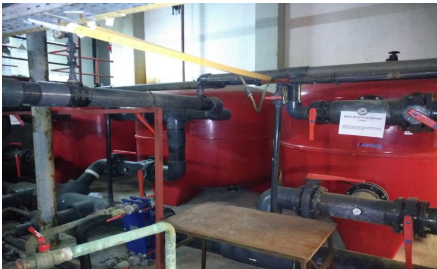
Εικόνα 2 Αμμόφιλτρα και το συνεργαζόμενο δίκτυο σωληνώσεων
