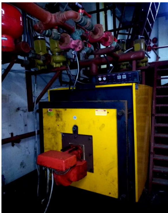
Εικόνα 3 Ο καυστήρας θέρμανσης του νερού χρήσης
