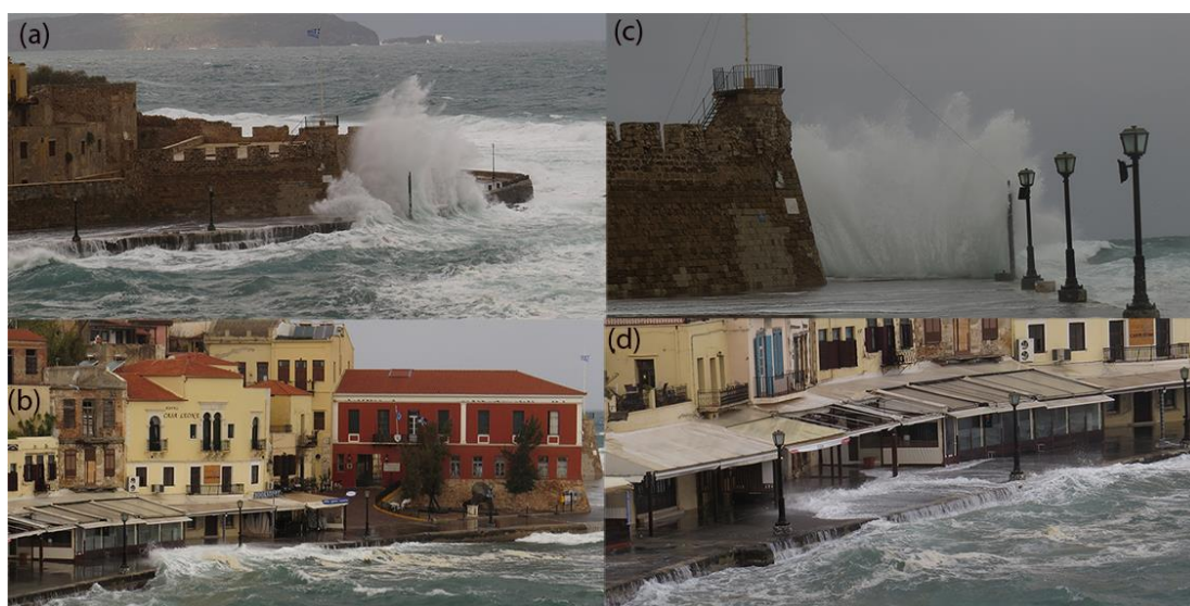
Εικόνα 6. Υπερήδηση κυματισμών στον Ενετικό λιμένα Χανίων κατά τη διάρκεια ισχυρών καταιγίδων. Υπερήδηση τύπου spray overtopping στο ΒΔ σημείο της εισόδου (a,c). Υπερήδηση τύπου green water στην δυτική προβλήτα της δυτικής λιμενολεκάνης (b,d).
