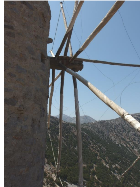
12. Φτερωτή ή “αντενωσιά” σε αποκατεστημένο ανεμόμυλο στο Σελί Αυπέλου. (Φωτονοαφία 2019)
