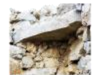
B 6 Συνδετήριος λίθος με την εγκάρσια τοιχοποιία
