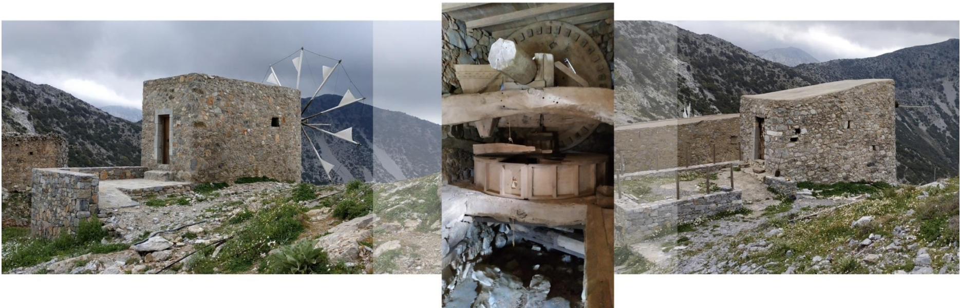
8. Απεκατεστημένος ανεμόμυλος με επανακατασκευή φτερωτής, Σελί Αμπέλου Λασιθίου. (αριστερά) Επανακατασκευή αλεστικού μηχανισμού, Σελί Αμπέλου Λασιθίου. (κέντρο) Συντήρηση ανεμόμυλου, Σελί Αμπέλου Λασιθίου. (δεξιά) (Φωτογραφία 2019)
