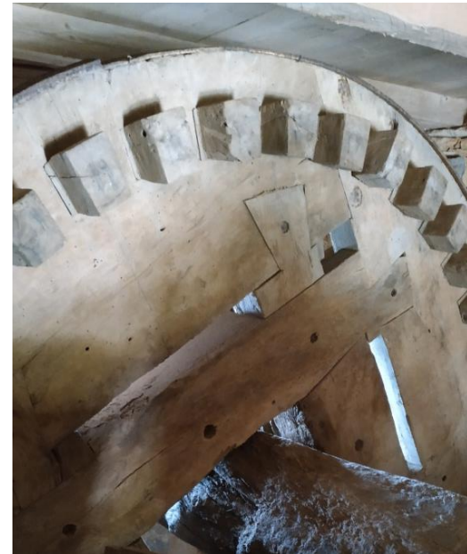
13. Ρόδα σε αποκατεστημένο ανεμόμυλο στο Σελί Αμπέλου. (Φωτογραφία 2019)
