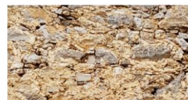
Δ2 Στερέωση εξωτερικής στρώσης τοιχοποιίας με τσιμεντιτικό κονίαμα
