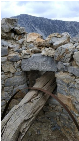
31. Εσωτερική παρειά βορειοδυτικής τοιχοποιίας, λεπτομέρεια ανοίγματος
