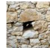
B 5 Θυρίδες διευκόλυνσης χτισίματος κατά την κατασκευή
