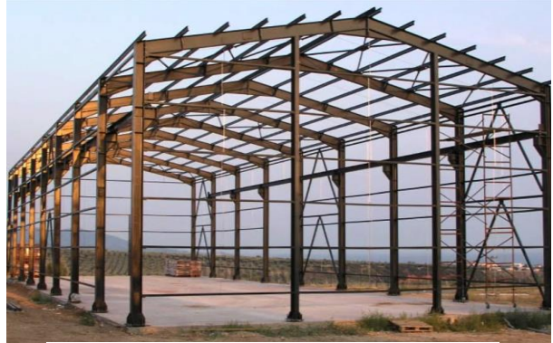
Σχήμα 2.3.1β: Σκελετός βιομηχανικού κτηρίου
