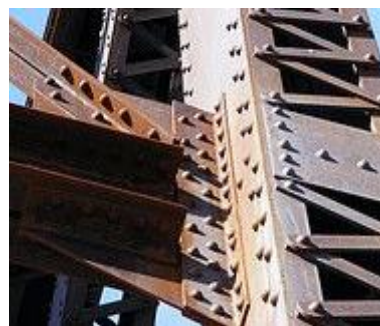
Σχήμα 2.6.1: Ένωση φλατζας και ιστού με τη χρήση ηλώσεων
