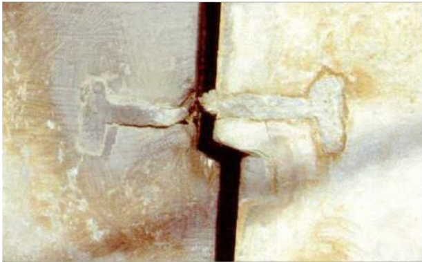
Σχήμα 2.1.1α: Τοποθέτηση σιδερένιων συνδέσμων μεταξύ λίθινων τοιχοποιιών
