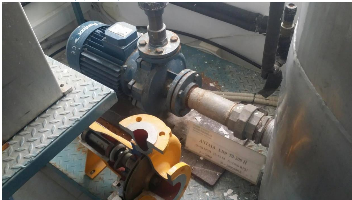
Εικόνα 3.11 Φυγοκεντρική αντλία συστήματος
