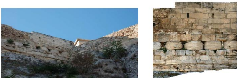
Εικόνα 3.10: Άποψη των διαφορετικών τεχνοτροπιών στο βόρειο τείχος ύστερα από μεταγενέστερες επεμβάσεις (ΥΣΜΑ, 2017).
