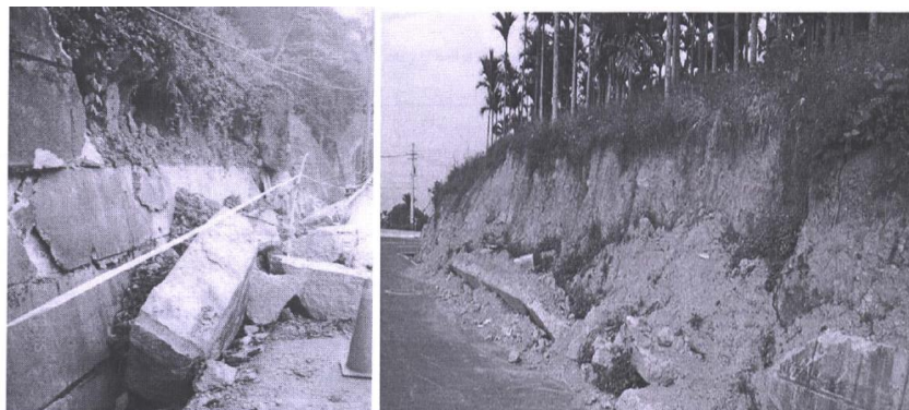
Εικόνα 1.5: Τυπικές αστοχίες τοίχων αντιστήριξης από τον σεισμό του Chi Chi στην Ταϊβάν το 1999 (Fang et al., 2003).
