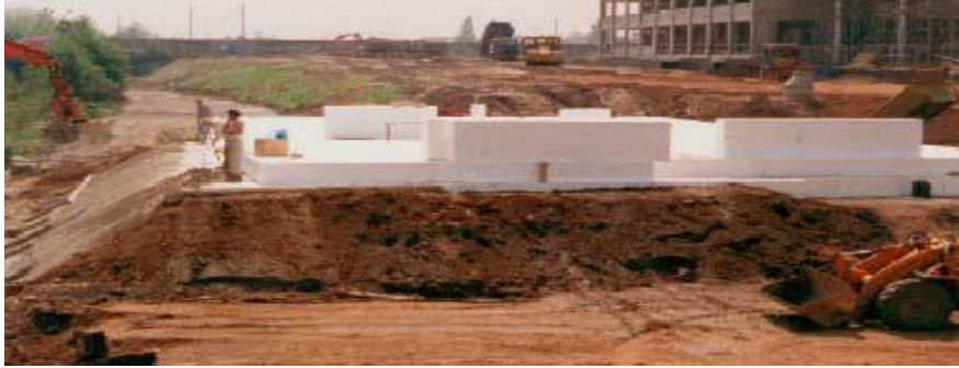
Εικόνα 2.10: Χρήση EPS σε επίχωμα πάνω από το σταθμό του μετρό στο Dusseldorf.
