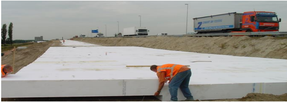
Εικόνα 2.12: Εφαρμογή EPS για ευστάθεια πρανούς (Πατενιώτης, 2020).
