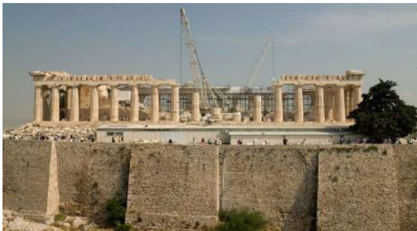
Εικόνα 3.8: Άποψη των τριών μεγάλων αντηρίδων που προστέθηκαν από τον Ν. Μπαλάνο (ΥΣΜΑ, 2017).
