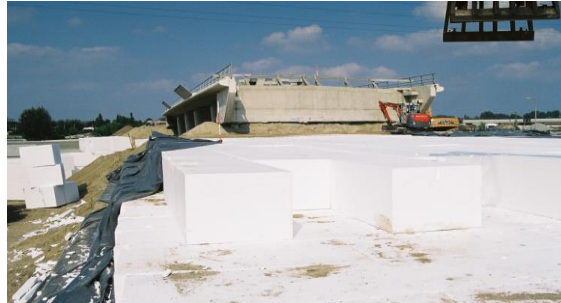
Εικόνα 2.8: Χρήση γεωαφρού EPS σε ακρόβαθρο γέφυρας (Πατενιώτης, 2020).
