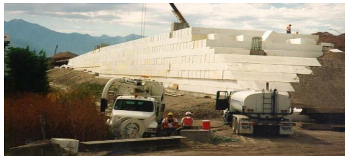
Εικόνα 2.5: Επίχωμα γεωαφρού EPS κατά την κατασκευή της διαπολιτειακής οδού I15 στο Salt Lake City (EPS Industry Alliance, 2012).
