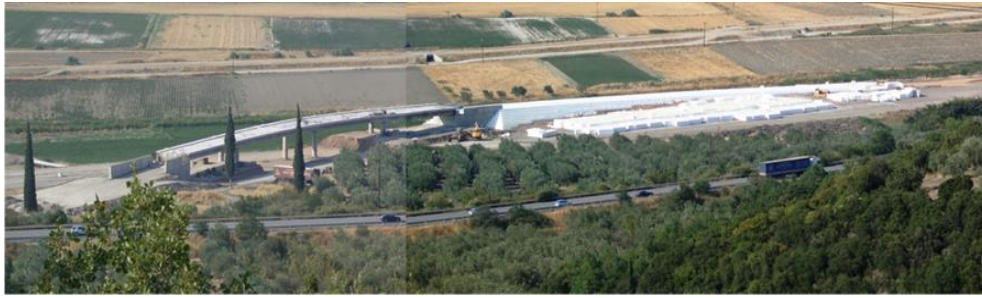
Εικόνα 2.6: Χρήση γεωαφρού EPS σε μεταβατικό οδικό επίχωμα στην περιοχή των Θεσσαλονίκων (ΠΙΕΤΕΠ 02-07-07-00, 2017).
