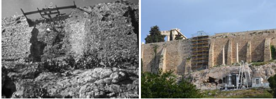
Εικόνα 3.9: Σημαντικές βλάβες του νοτίου τείχους κατά το παρελθόν και εργασίες νεότερων επεμβάσεων (Ψαρρόπουλος, 2019).
