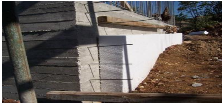
Εικόνα 2.14: Εφαρμογή EPS σε τοίχο αντιστήριξης σκυροδέματος (Πατενιώτης, 2020).
