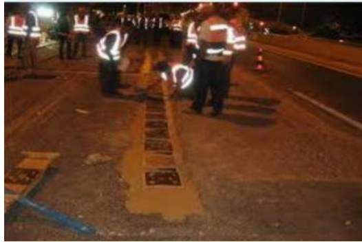
Εικόνα 8: Τοποθέτηση πιεζοηλεκτρικών πλακών στο οδόστρωμα στο Ισραήλ
