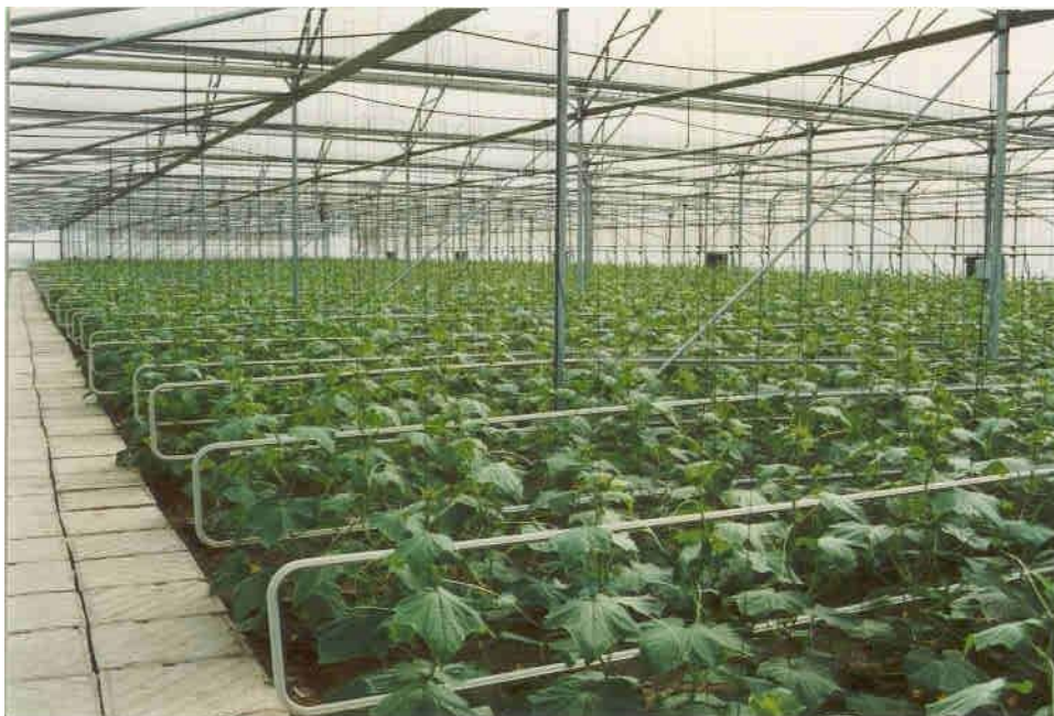
Εικόνα 6.2: Σωληνώσεις κεντρικού συστήματος θέρμανσης [5]
