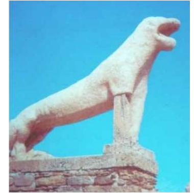
ΕΙΚΟΝΑ 1.10. ΔΡΑΣΗ ΑΛΑΤΩΝ ΣΕ ΜΑΡΜΑΡΟ ΑΠΟ ΑΙΩΡΟΥΜΕΝΑ ΣΩΜΑΤΙΔΙΑ ΘΑΛΑΣΣΙΝΟΥ ΝΕΡΟΥ (ΣΤΥΛΟΛΙΘΟΙ)
