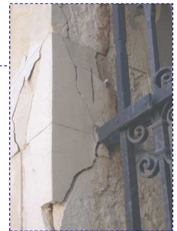
ΕΙΚΟΝΑ 1.10. ΔΡΑΣΗ ΑΛΑΤΩΝ ΣΕ ΜΑΡΜΑΡΟ ΑΠΟ ΑΙΩΡΟΥΜΕΝΑ ΣΩΜΑΤΙΔΙΑ ΘΑΛΑΣΣΙΝΟΥ ΝΕΡΟΥ (ΣΤΥΛΟΛΙΘΟΙ)
