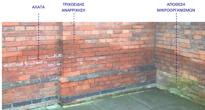
ΕΙΚΟΝΑ 1.8. ΤΥΠΙΚΗ ΛΙΘΟΔΟΜΗ ΑΠΟ ΟΠΤΟΠΛΙΝΘΟΥΣ – ΔΡΑΣΕΙΣ ΔΙΑΒΡΩΣΕΩΝ
