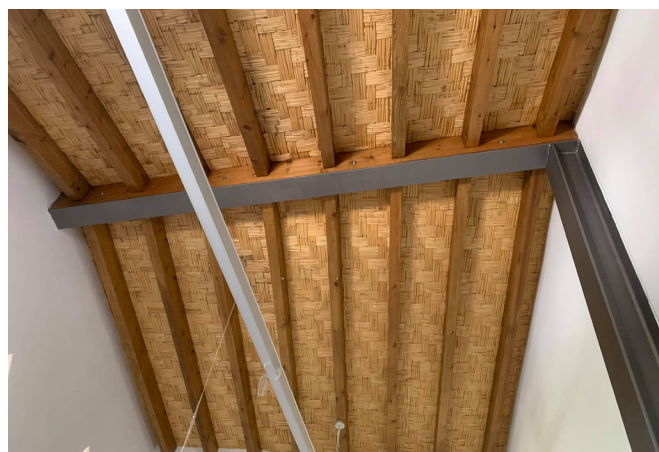
Εικόνα 32. Ξύλινο δοκάρι (Νευκά)
