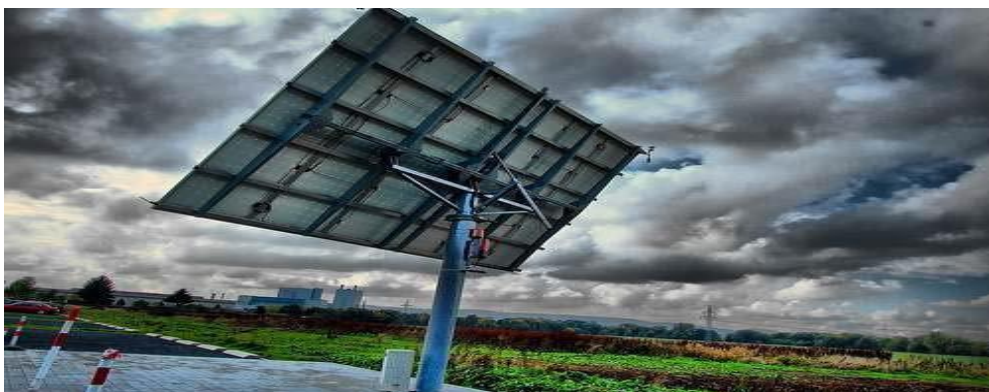
Εικόνα 21. Σύστημα ιχνηλάτησης διπλού άξονα [6]
