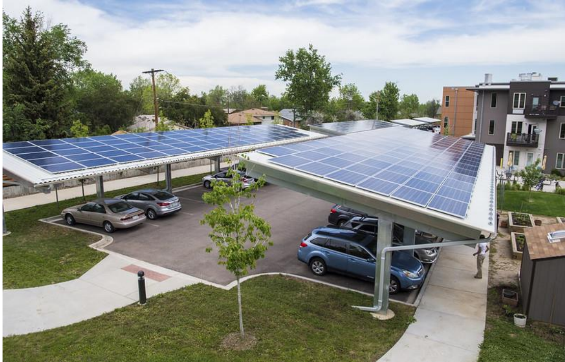
Εικόνα 1.9.1: Παράδειγμα εφαρμογής BIPV για σκίαση σε χώρο στάθμευσης, κατασκευασμένο από την εταιρία National Renewable Energy Laboratory, 2017.
