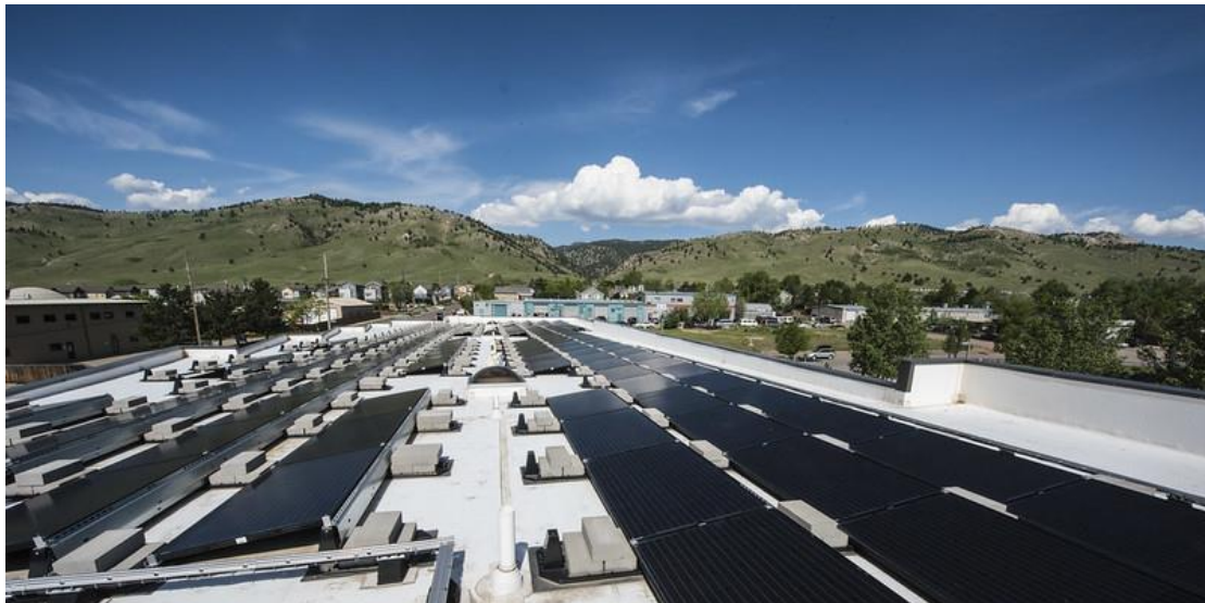
Εικόνα 1.10.1: Παράδειγμα εφαρμογής BAPV σε στέγη κτιρίου, από την NREL(National Renewable Energy Laboratory),2017.
