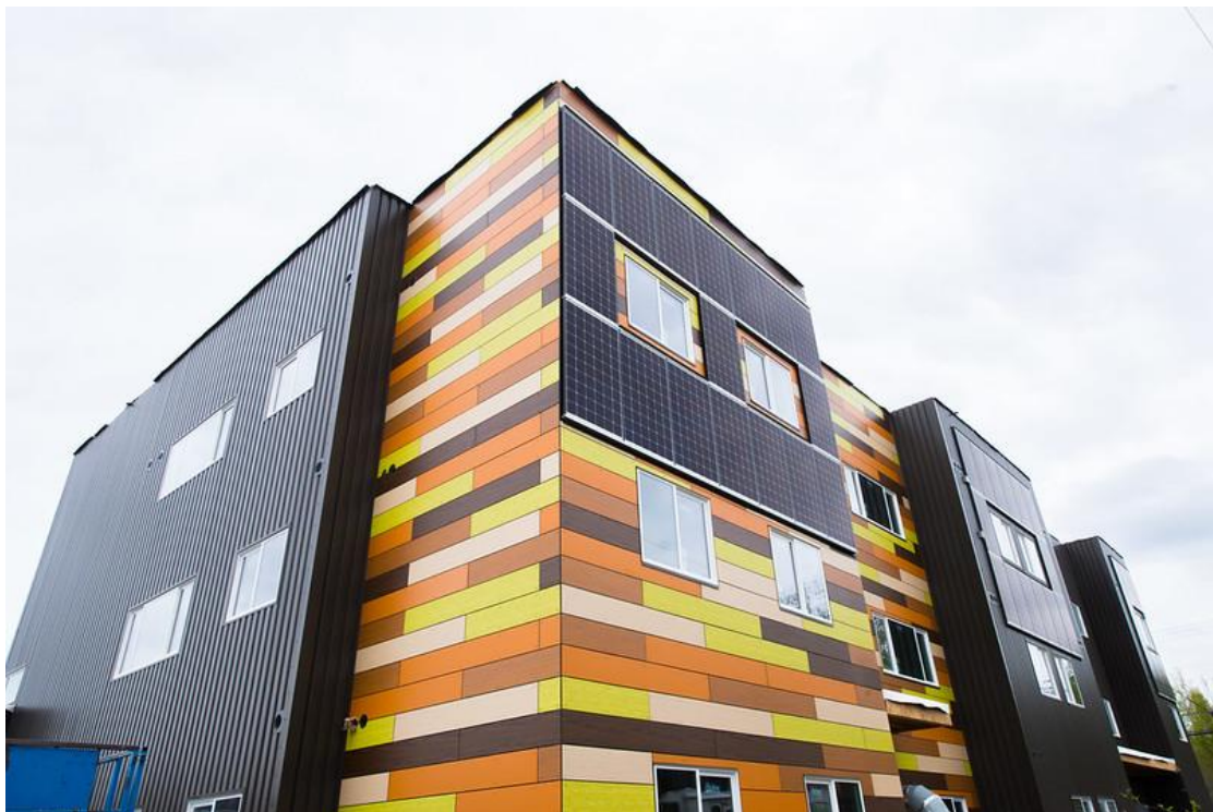
Εικόνα 1.6.1: Παράδειγμα εφαρμογής BIPV σε πρόσοψη σπιτιού στο Άνκορατζ της Αλάσκας από την Artic Solar Ventures Corporation, η φωτογραφία τραβήχτηκε από τον Dennis Schroeder, NREL, 2018.
