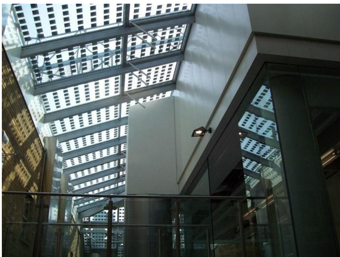
Εικόνα 1.8.1:Παράδειγμα ενσωμάτωσης BIPV στην σκεπή ενός σχολείου, σχεδιασμένο από την κατασκευαστική εταιρία Romag.
