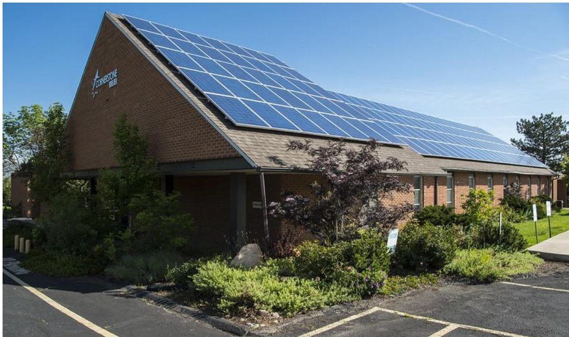
Εικόνα 1.7.1: Παράδειγμα εφαρμογής ενσωματωμένων φωτοβολταϊκών στην οροφή εκκλησίας, η φωτογραφία τραβήχτηκε από τον Dennis Schroeder, NREL, 2017.
